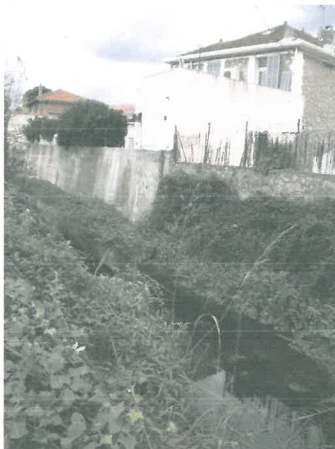
Végétation bordant la Reppe – lierres, ronces – au niveau de la zone de projet amont – source : Ingérop Conseil & Ingénierie
