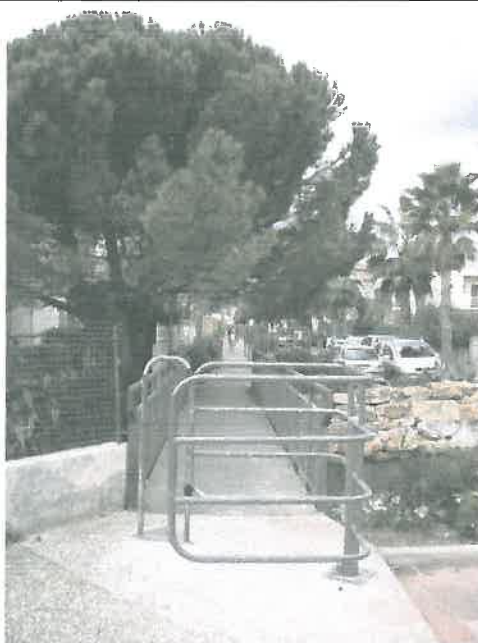
Barrière de la passerelle avale – source : Ingérop Conseil & Ingénierie
