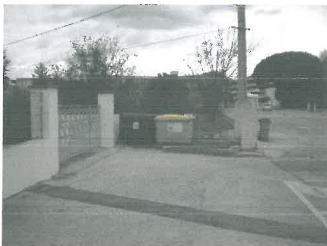
Emplacements de collecte de déchets (zone de projet amont)
