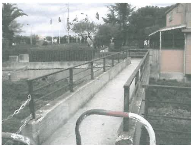
Barrière de la passerelle amont – source : Ingérop Conseil & Ingénierie
