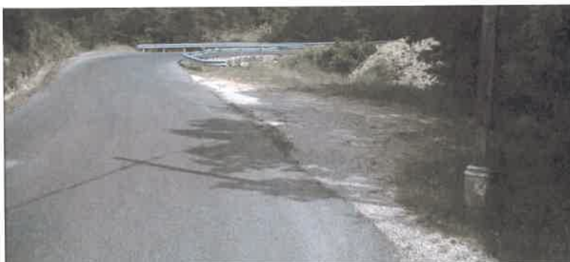
Figure 5 : Illustration de la zone de délaissée (Photo: SCE)
