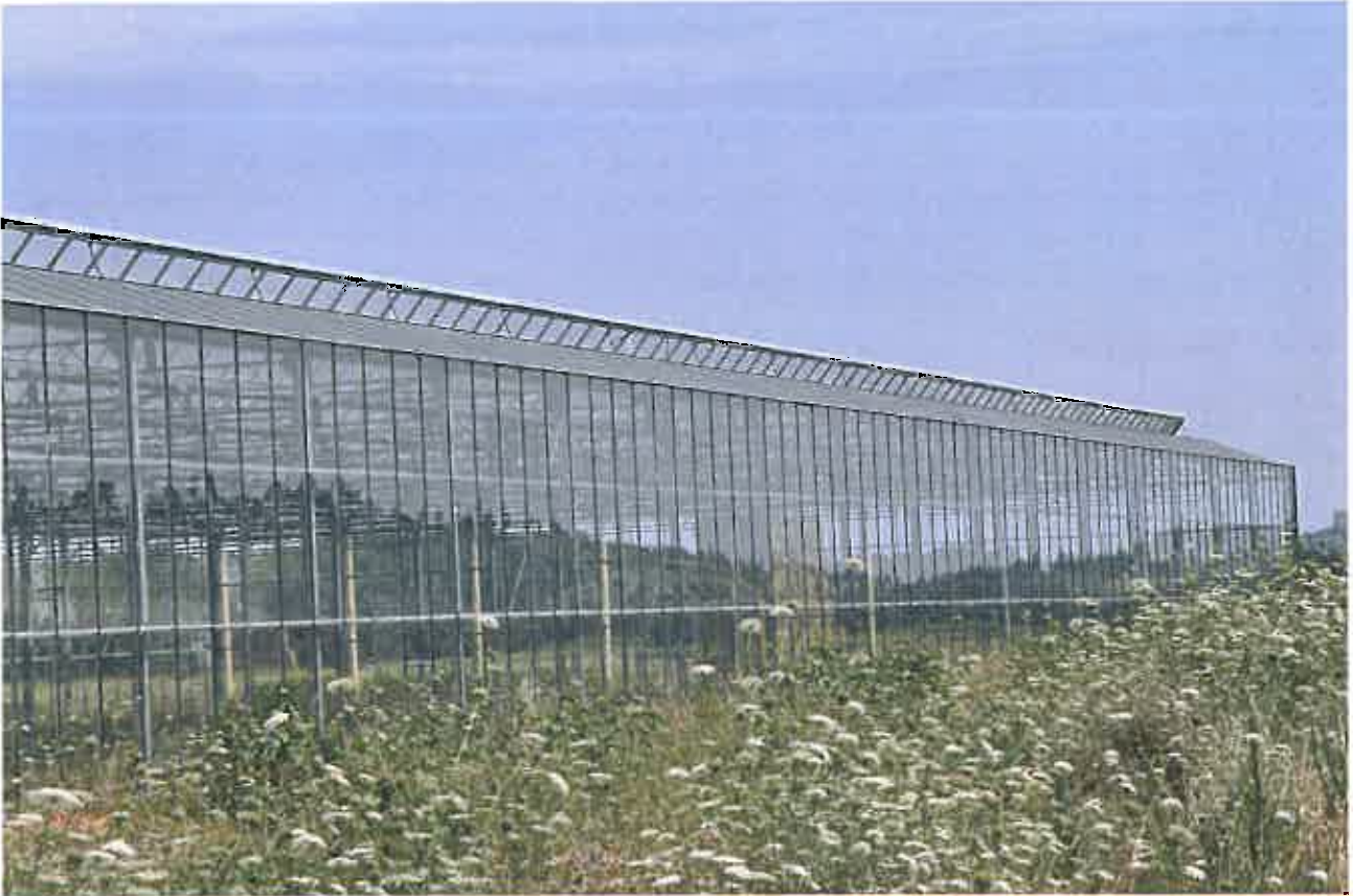
Modèle des serres en verre qui seront installées sur le site de Salon-de-Provence
