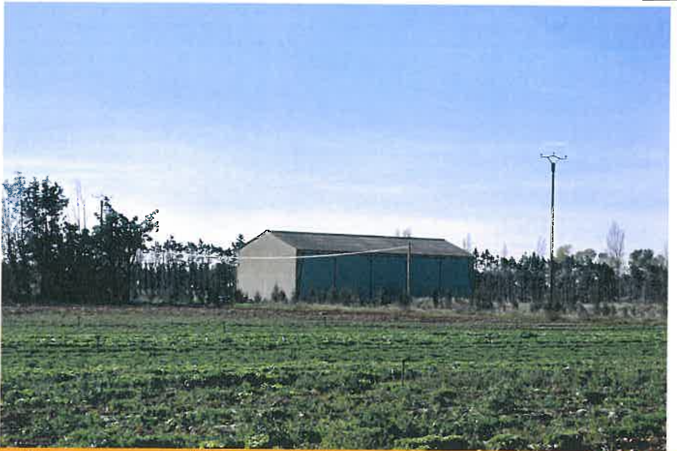
2/ Perception ouverte, côté Ouest, sur le bâtiment situé de l'autre côté du chemin d'accès
