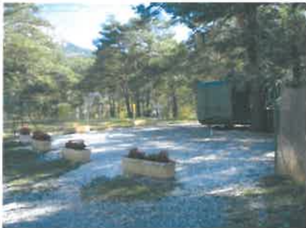
⇨ Le traitement du sol et les bacs à fleurs vieillissants.
