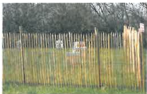
⇨ Exemple de clôtures ganivelles
