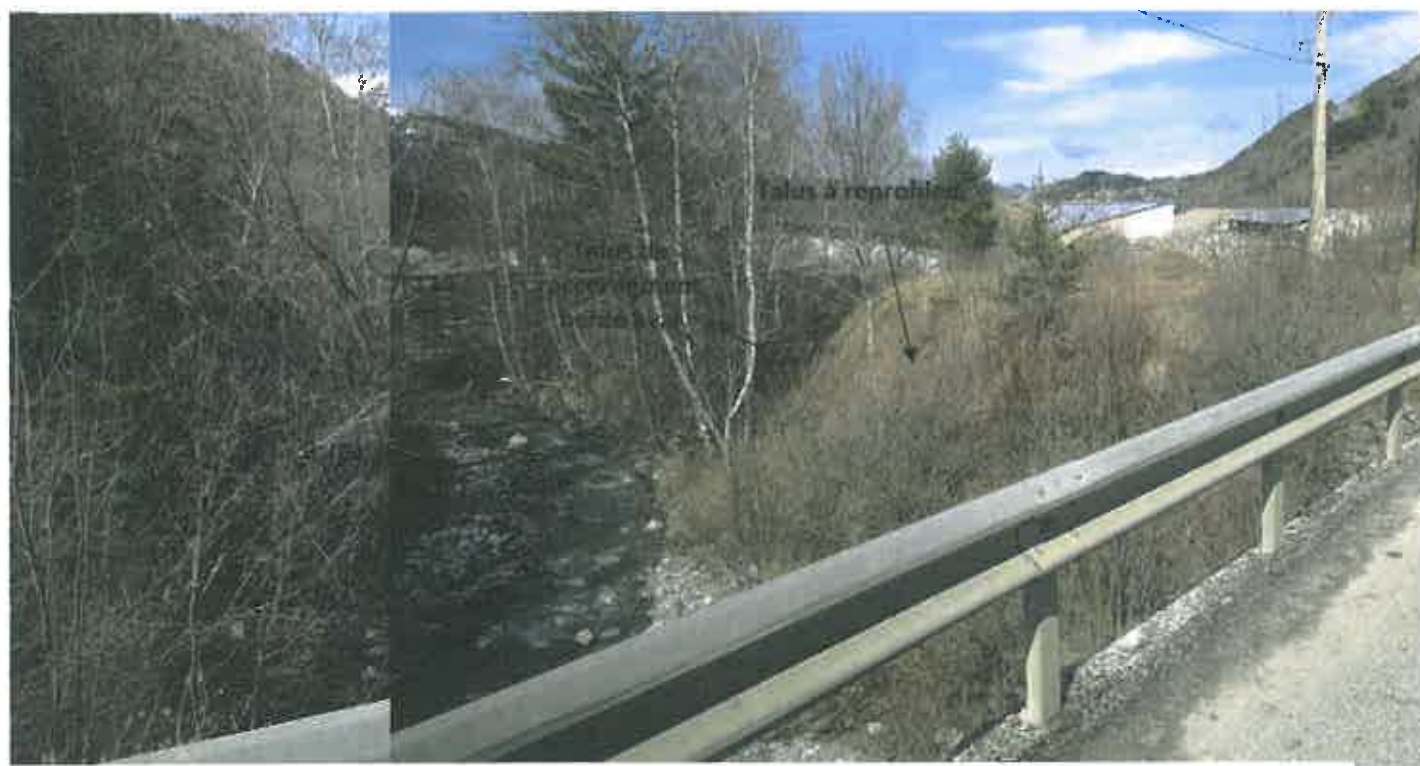
Photo 3 - Berge et talus rive droite, avec remblai à supprimer et talus à reprofiler pour accueillir le nouvel ouvrage et les protections de berge
