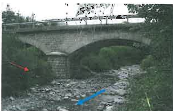
4 - Aperçu du remblai obstruant l'arche rive
