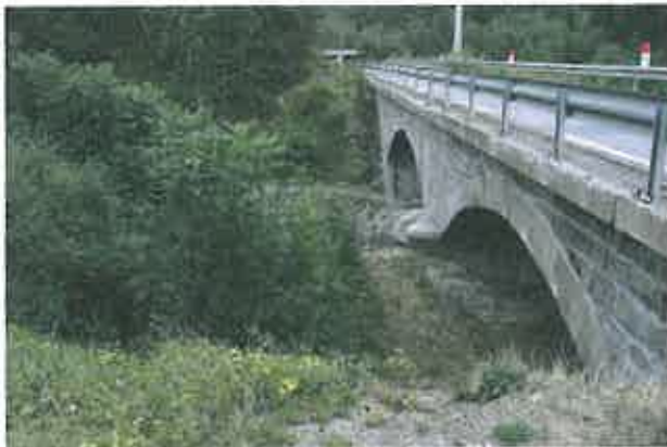
1 - Amont du pont depuis la rive droite (banc végétalisé à gauche)
