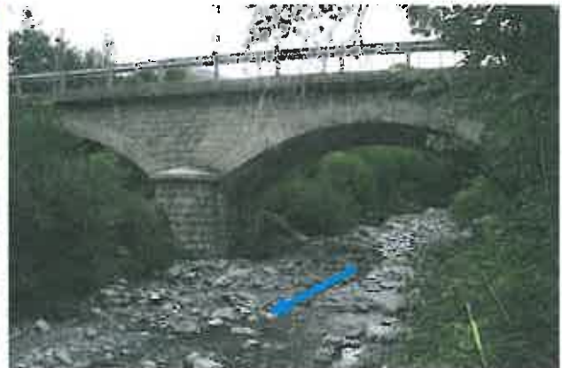
4 - Aperçu du remblai obstruant l'arche rive
