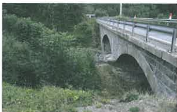
1 - Amont du pont depuis la rive droite (banc végétalisé à gauche)
