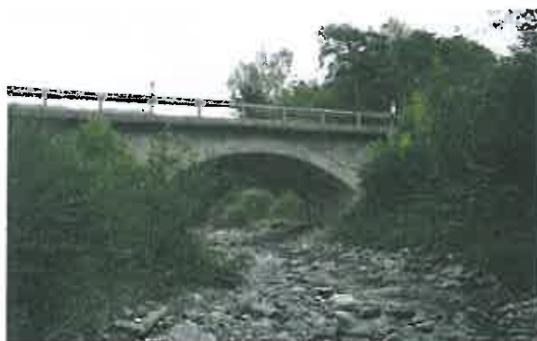
2 - Lit mineur à l'aval du pont
