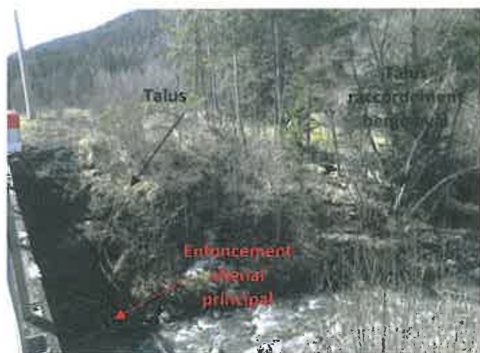
Photo 1 - Berge rive gauche et talus sur lequel prendra appui le pont
