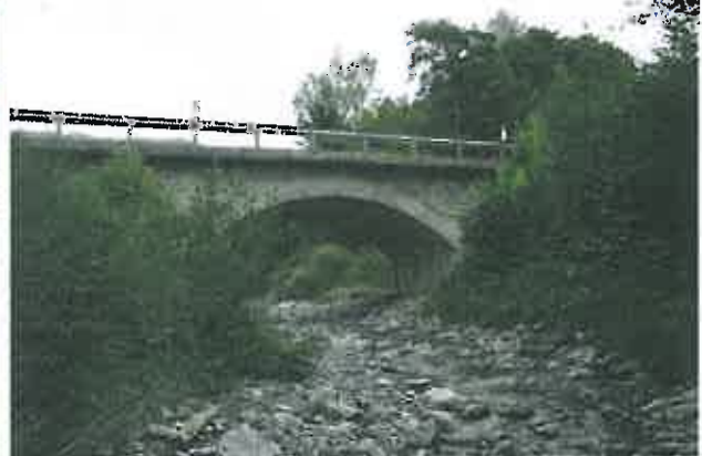
2 - Lit mineur à l'aval du pont
