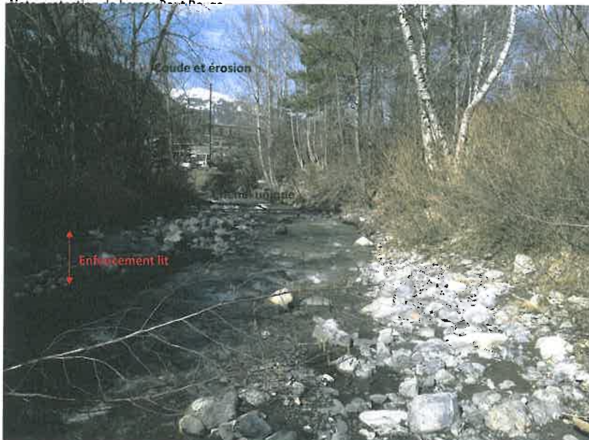
Photo 4 - Section aval, à chenal unique de largeur réduite (se réduisant encore à l'aval)
