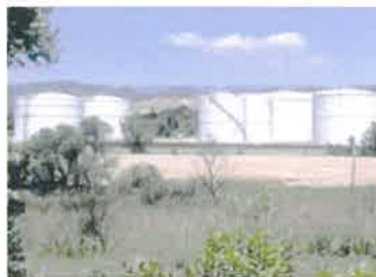
Stockage GDF à Fos-sur-Mer
