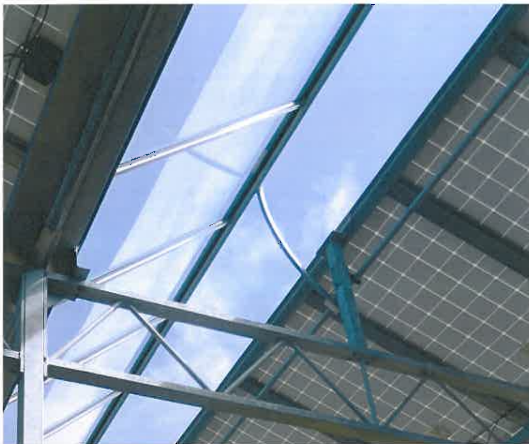
Détail d'un ouvrant «cabriolet» - Projet ci-dessus (82)
