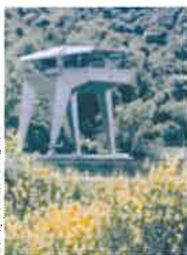
Micro-centrale EDF de Provence
