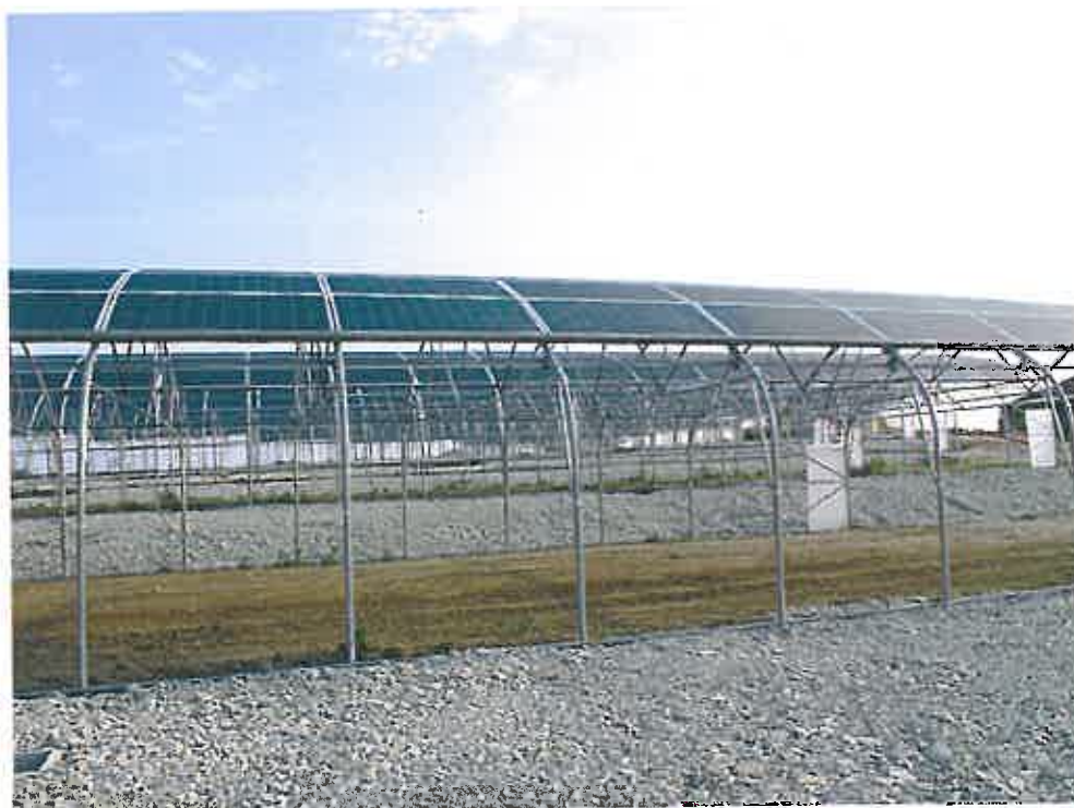
Perspective des installations en cours d'aménagement Site de Saint Germain-du-Bel-Air (46)
