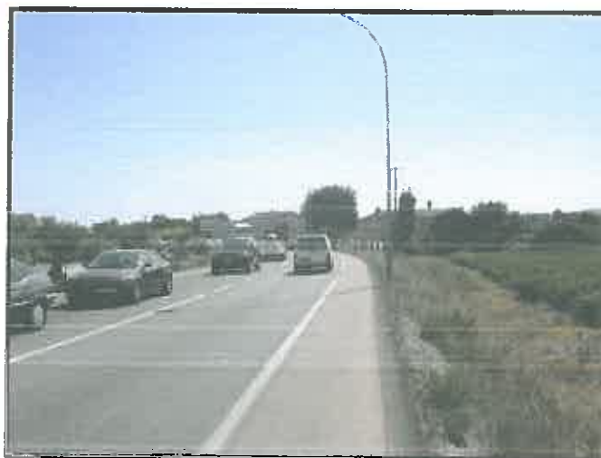
Vue du carrefour orientée vers Est depuis la RD61, la circulation aux abords de l'intersection reste très importante - Source : Ingérop Conseil & Ingénierie
