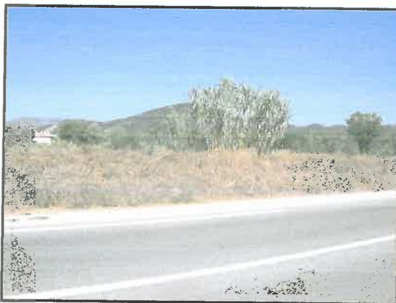
Vue vers le Nord de la RD14, dévoilant un milieu plus rural avec de hauts talus enherbés et des parcelles de pelouses sèches
