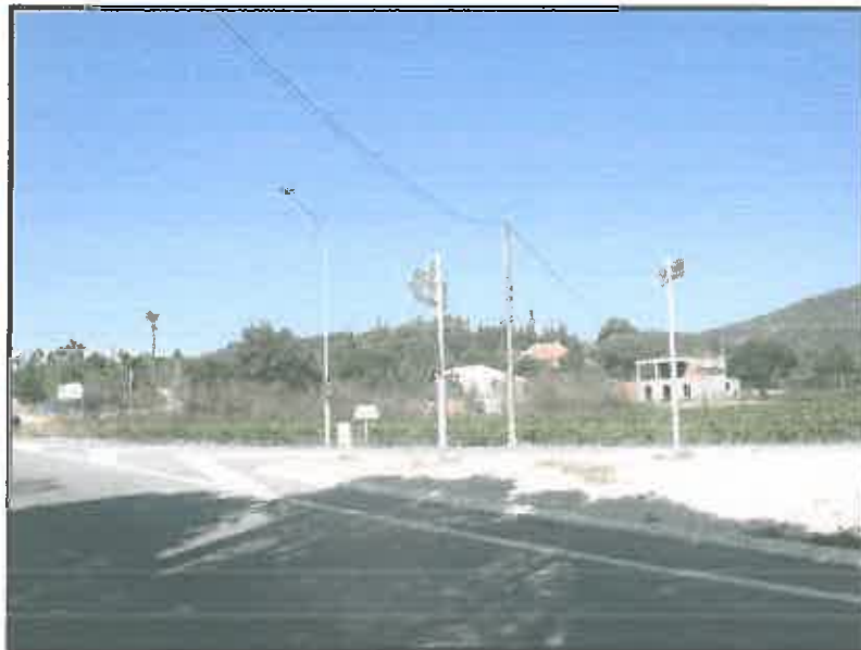
Le réseau d'éclairage - Source : Ingérop Conseil & Ingénierie
