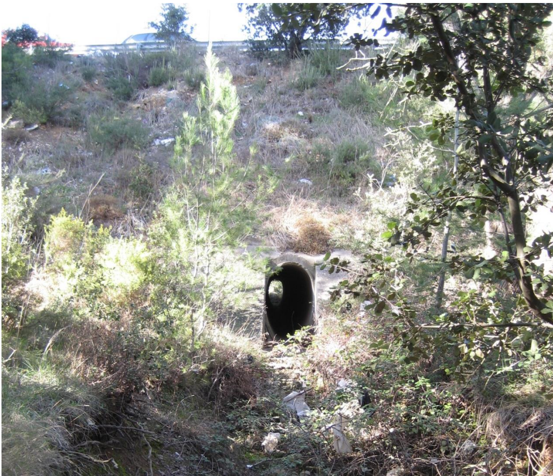
Fig. 27. Photographie descriptive des écoulements superficiels aux abords du projet- 5
