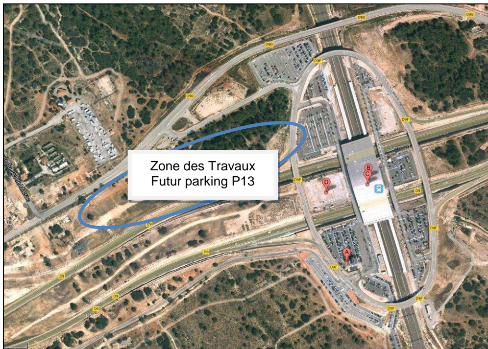
Vu aérienne de la zone
