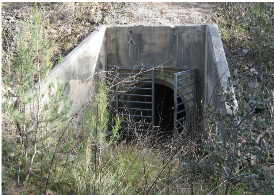
Fig. 29. Photographie descriptive des écoulements superficiels aux abords du projet- 7
