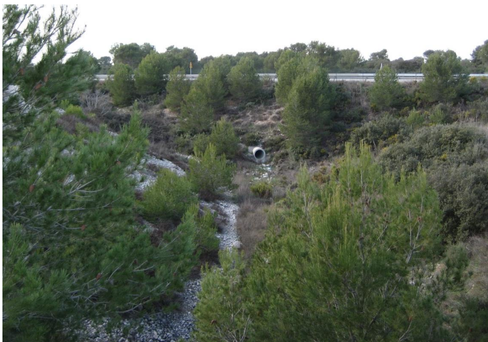
Fig. 26. Photographie descriptive des écoulements superficiels aux abords du projet- 4
