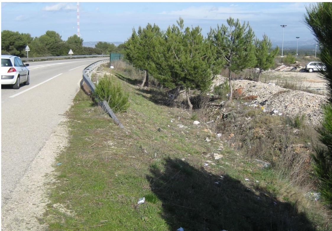
Fig. 25. Photographie descriptive des écoulements superficiels aux abords du projet- 3
