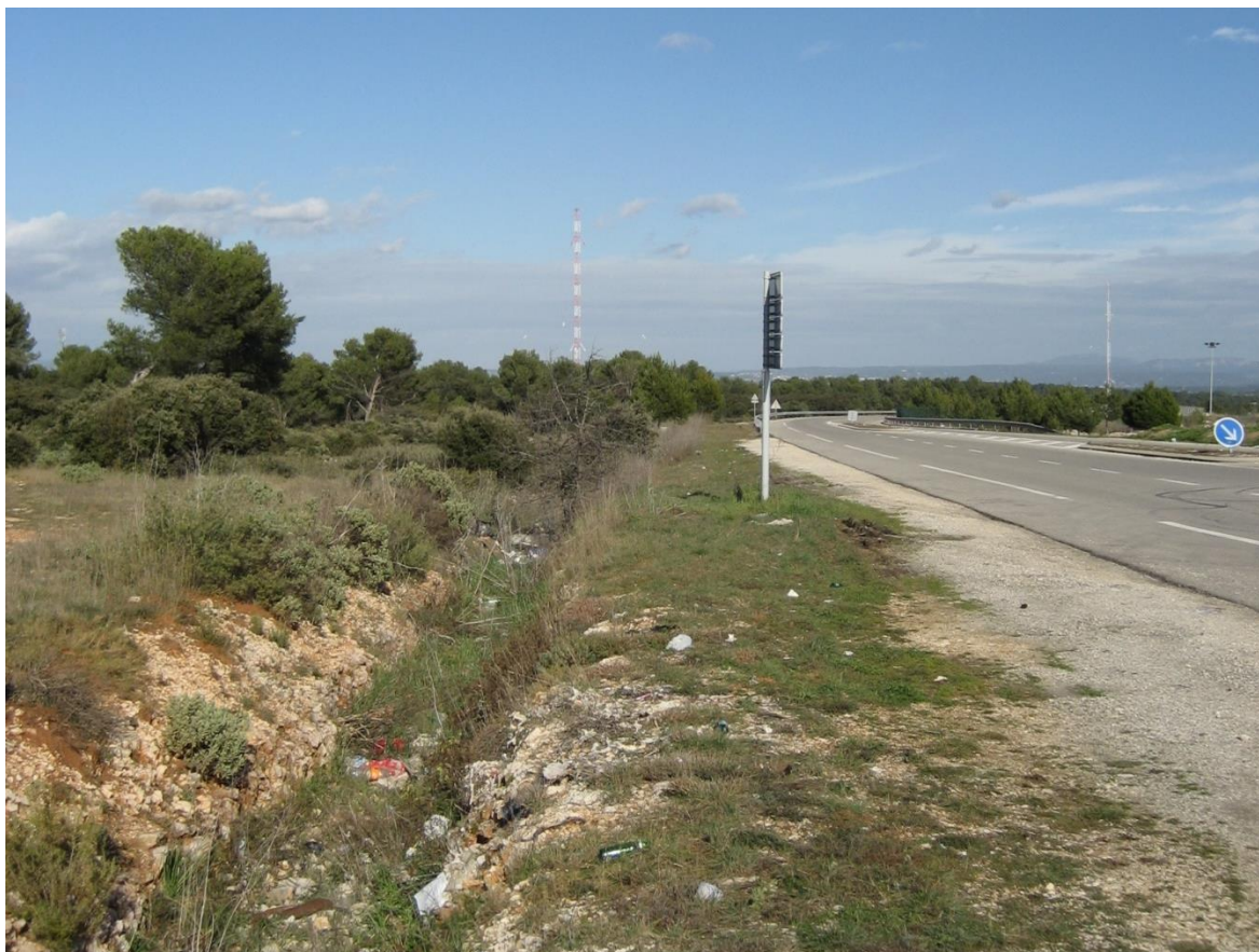
Fig. 24. Photographie descriptive des écoulements superficiels aux abords du projet- 2
