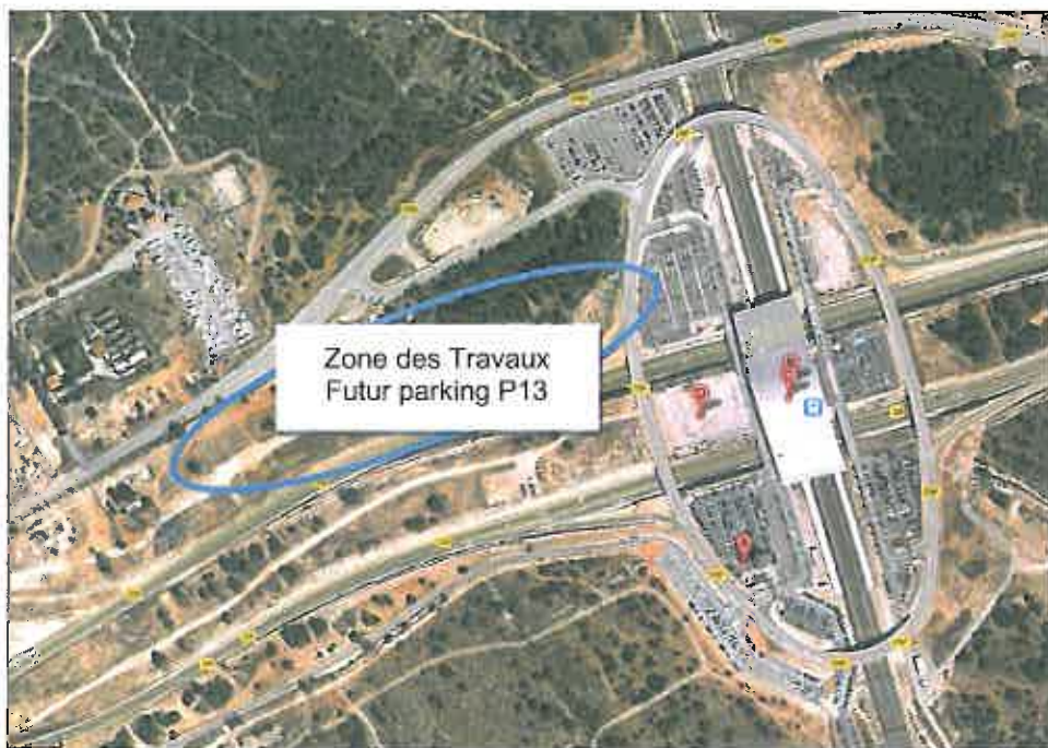
Vu aérienne de la zone
