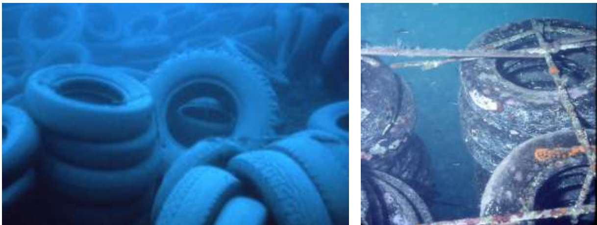
Figure 11 – 5 : Ensemble de 3 à 5 pneus reliés entre eux et composant des amas chaotiques – 6 : Ensemble de plusieurs dizaines de pneus formant des structures hautes
