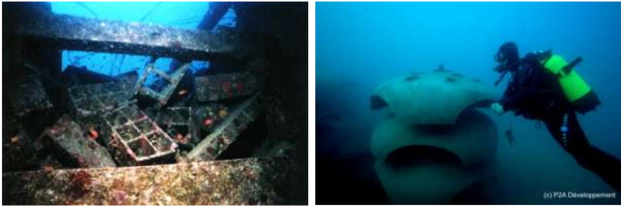
Figure 8 - 1 : module de type Bonna 158 m 3 rempli de parpaings (zmp de Golfe-Juan) - 2 : récifs P2A immergés à Cagnes sur mer
