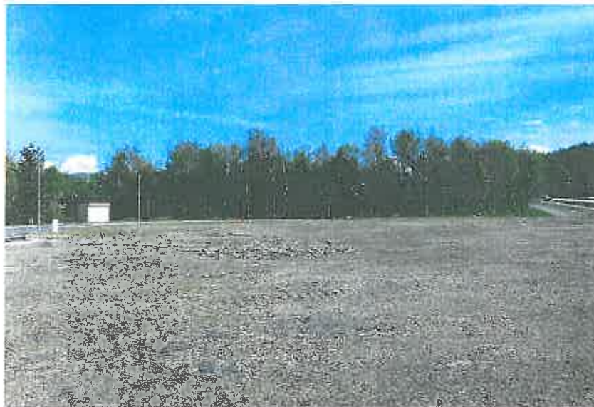
Talus boisé du canal de Ventavon – vue prise vers le nord RN 85 à droite – Pont sur le Rousine à gauche derrière le poste électrique
