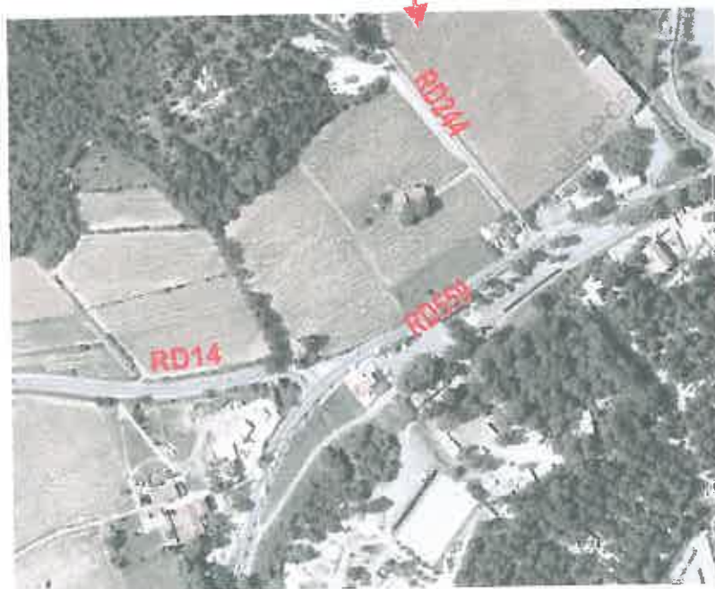
PHOTOGRAPHIE AERIENNE DU CARREFOUR RD14/RD559
