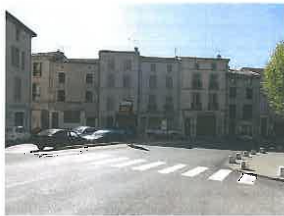
photo 5 - sce. SEGC avril 2014
