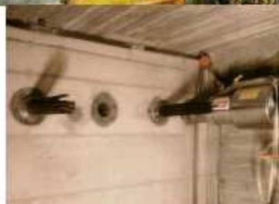
Exemple de vérins utilisés pour la mise en tension des câbles longitudinaux
