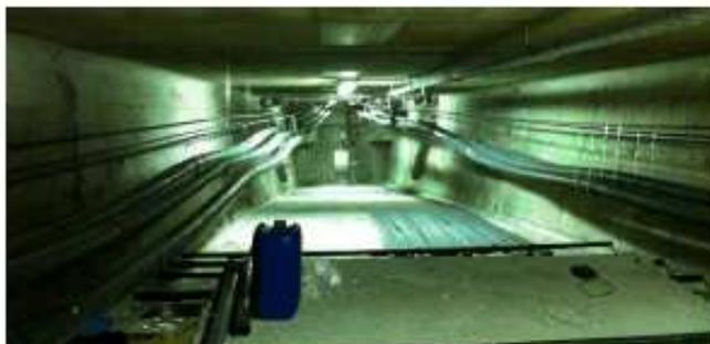
Exemple passage des câbles longitudinaux dans le caisson
