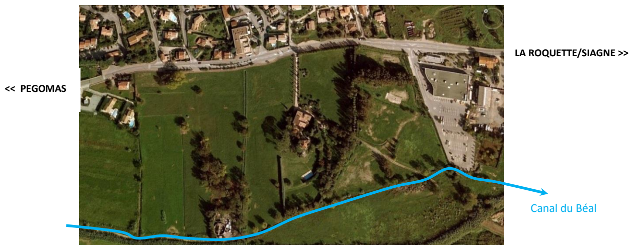
Figure 1 - Vue aérienne 2004 (avant la construction des logements 2004-2009) et de la voie express (2010)
