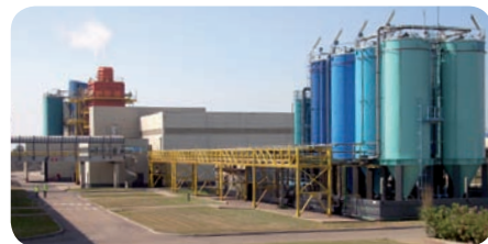
Établissement Solamat-Merex à Fos-sur-Mer. (dép. 13) Source : DREAL
