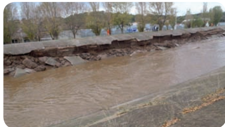
Digues du REYRAN endommagées dans le Var. (dép. 83) Source : IRSTEA
