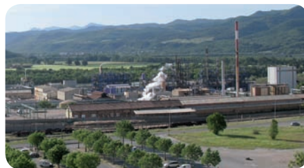
Site Arkema Saint-Auban (dépt. 04) Source : DREAL
