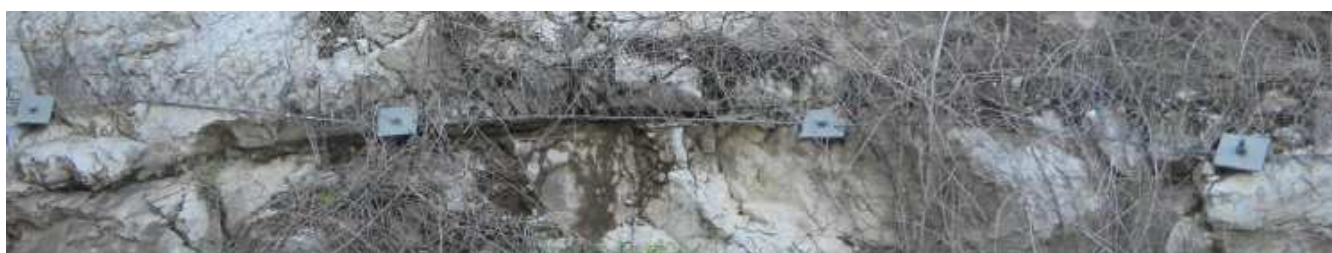
Figure 3: Photographies de grillage plaqué ancré
