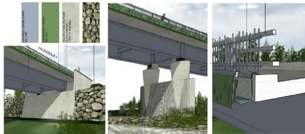
Figure 12 : Illustration de la culée C4, d'une pile du pont et des équipements (dispositif de retenue et garde-corps)
