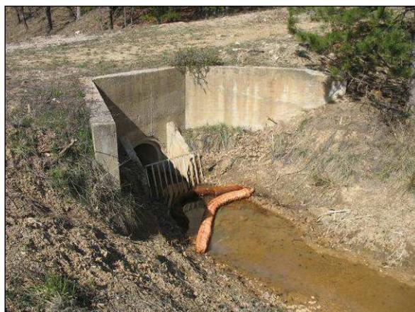
**Exemple de dispositifs dédiés à l'absorption des hydrocarbures**
