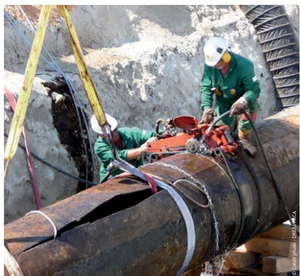
Intervention sur le site de la réserve naturelle Coussouls de Crau suite à la rupture de la canalisation de l'oléoduc en août 2009.
