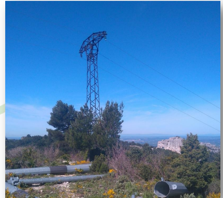
Enlèvement des pylônes au sol
