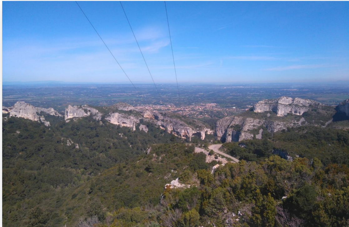
Dépose de la ligne aérienne sur 1,9 km
