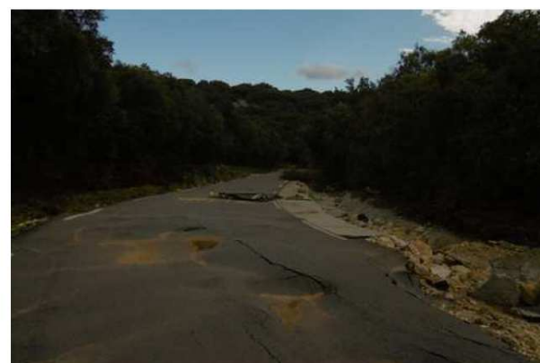
RD 174 reliant Laval-St-Roman détruite sur plusieurs centaines de mètres (structure, couche de roulement, fossés bétonnés, enrochements). Fermée à la circulation.
