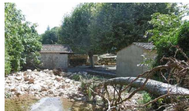
Atterrissements de gravats, destruction du revêtement de chaussée, de murs, du réseau pluvial
