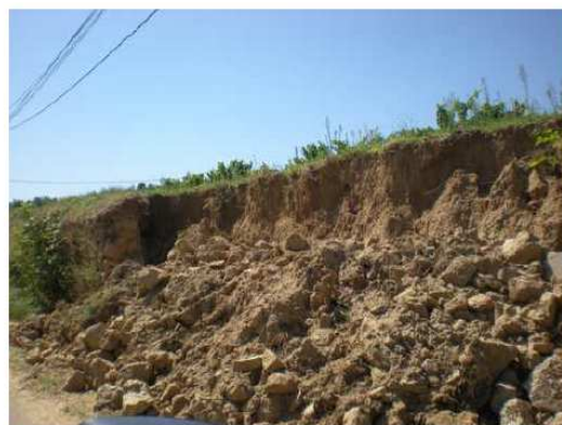
Glissement de terrain depuis une propriété privée sur le domaine public (chaussée + fossé)
