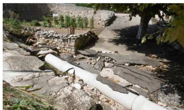
Atterrissements de gravats, destruction du revêtement de chaussée, de murs, du réseau pluvial
