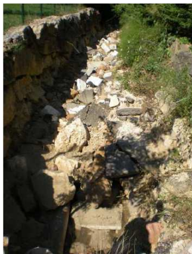
collecteur du réseau pluvial bétonné, détruit et encombré
