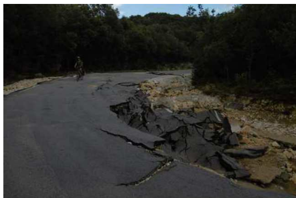
RD 174 reliant Laval-St-Roman détruite sur plusieurs centaines de mètres (structure, couche de roulement, fossés bétonnés, enrochements). Fermée à la circulation.
