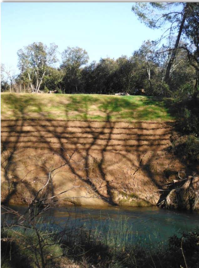
Figure 9 : Exemple de confortement de berges de l'Argens en lit de plants et plançons et toile coco avec ensemencement et boutures sur le domaine du Château d'Astros (83) (Réalisation des travaux en décembre 2014 - photo SCP en février 2015)
