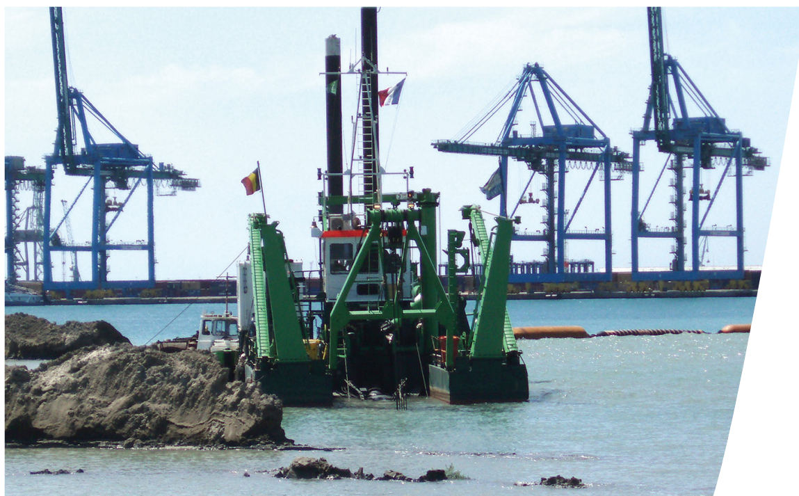
Travaux portuaires (© DDTM13)
