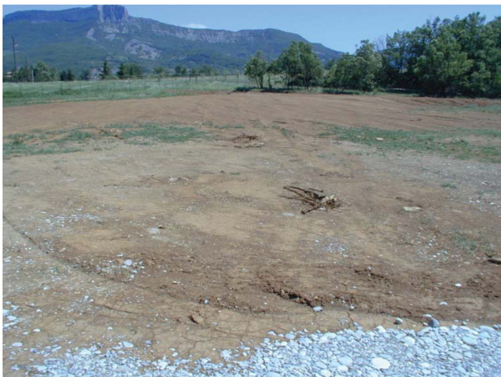
Site de Valernes (Alpes-de-Haute-Provence), réhabilité par SANOFI-AVENTIS (ancienne décharge de DIS liquides – solvants –)
