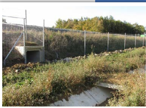
Passage inférieur parfaitement encadré par le grillage permettant de guider la faune vers les entrées © COSEA
