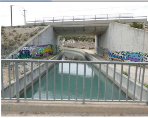
Passage du canal de Marseille sous la voie ferrée et portail (rive gauche) empêchant le passage de la faune sauvage © Nicolas FUENTO
