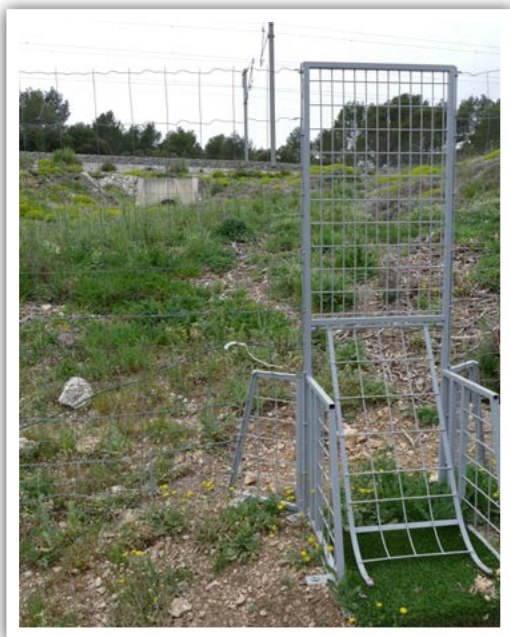
Échappatoire à grande faune au niveau de l'ouvrage ① © Nicolas FUENTO
