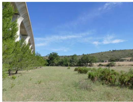
Milieux naturels intéressants sous le viaduc à proximité desquels ont été observés les Lézards ocellés © Nicolas FUENTO
