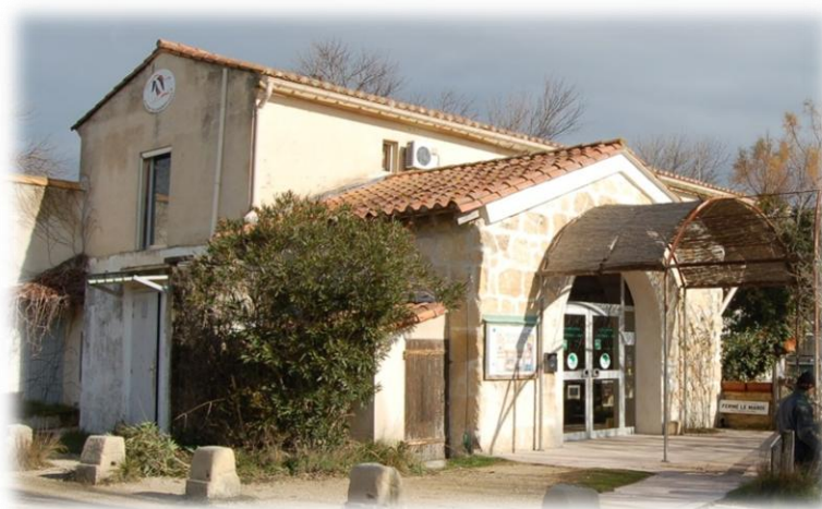
Photo 35: Centre d'accueil de la Capelière
