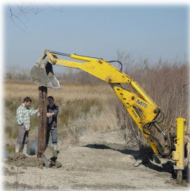
Photo 12: Travaux sur la Réserve
