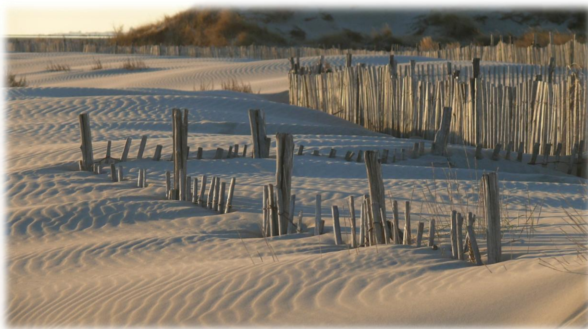
Photo 26 : Système dunaire protégé par des ganivelles
