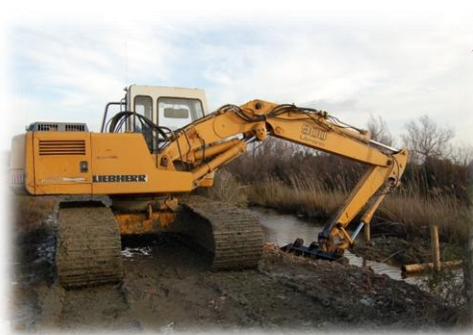
Photo 7 : Travaux sur la Réserve
