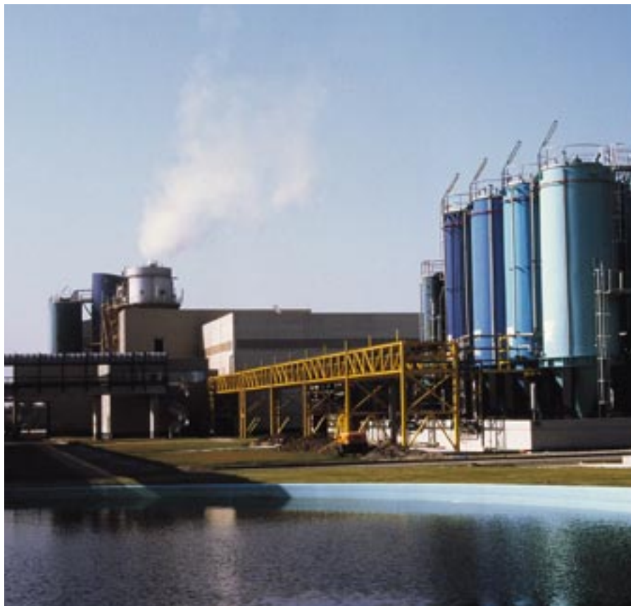
Usine de traitement des déchets industriels spéciaux (DIS) de Solamat Merex à Fos-sur-mer.
