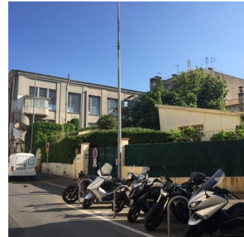
Photo 9 - Vue depuis la Rue Lacan Vue arrière de la Poste et bâtiment à démolir
