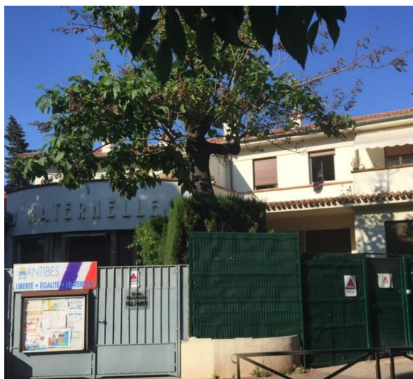
Photo 6 - Vue depuis l'avenue Paul Doumer de l'école Primair (A démolir)
