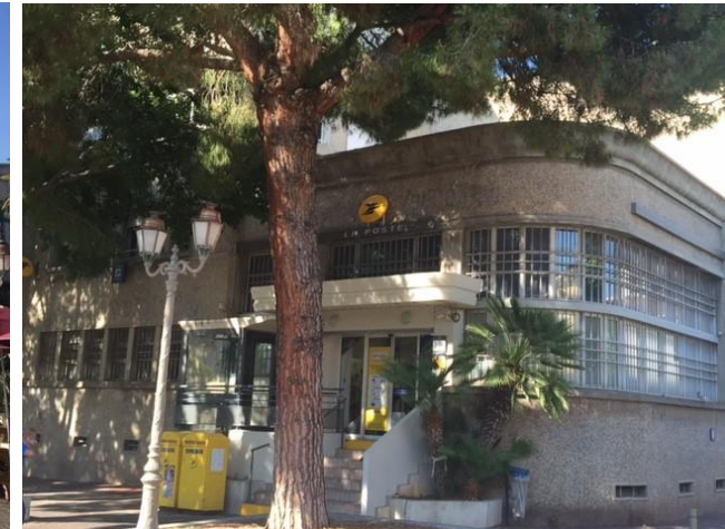
Photo 4 - Vue depuis la Place des Martyrs sur la Poste (Périmètre Sud de l'îlot A A1 – Bâtiment hors projet)
