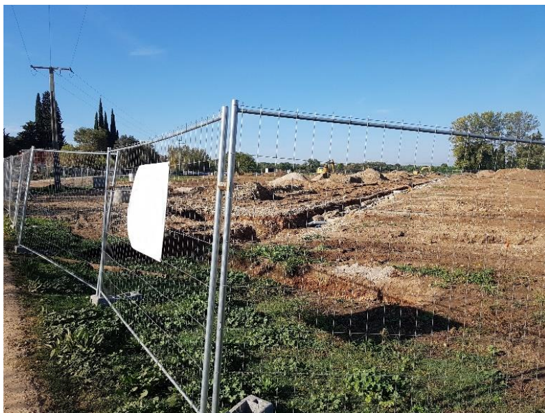
Figure 27 : Clôture de chantier (Source : H. MAIGRE lors d'un suivi de chantier pour EcoTonia)
