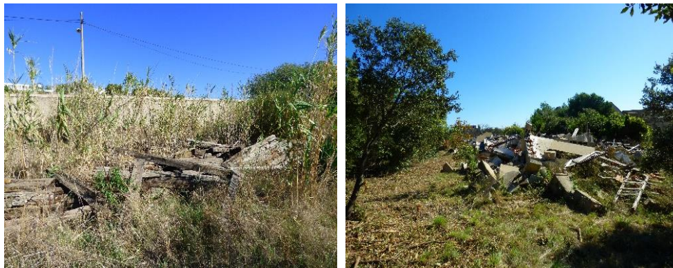
Figure 26 : Exemple de matériaux présents sur le site à déplacer aux abords du site (Source : C. LIGER et N. CAMOIN pour Ecotonia)
