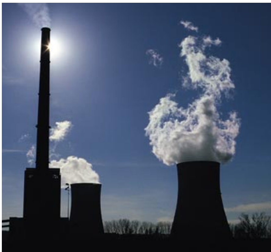
Centrale de Provence à Meyreuil.
