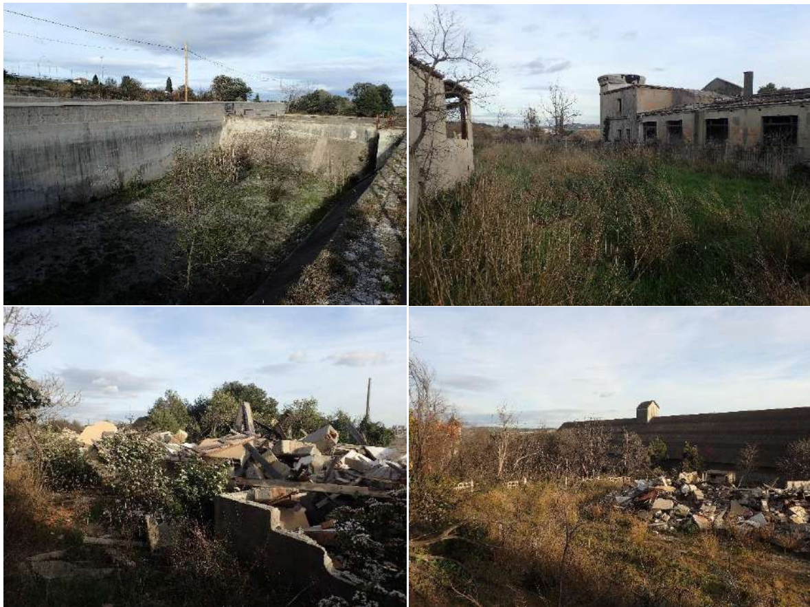
Figure 24 : Milieux artificialisés du site : bassin vide (en haut à gauche), bâti (en haut à droite), gravats (en bas) (Source : A.-H. PARADIS pour Ecotonia)
