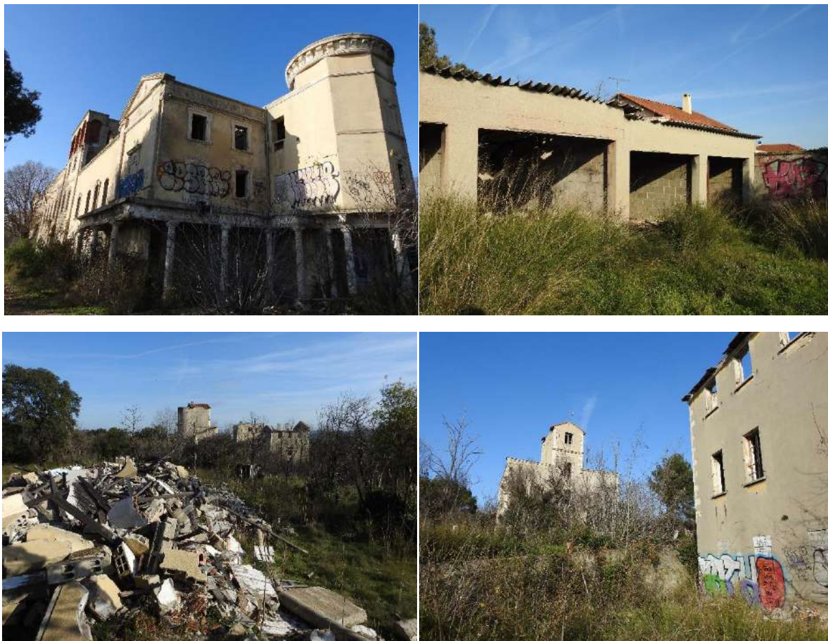
Figure 38 : Bâtiments sur le site d'étude (Source : Benjamin Vollot)
