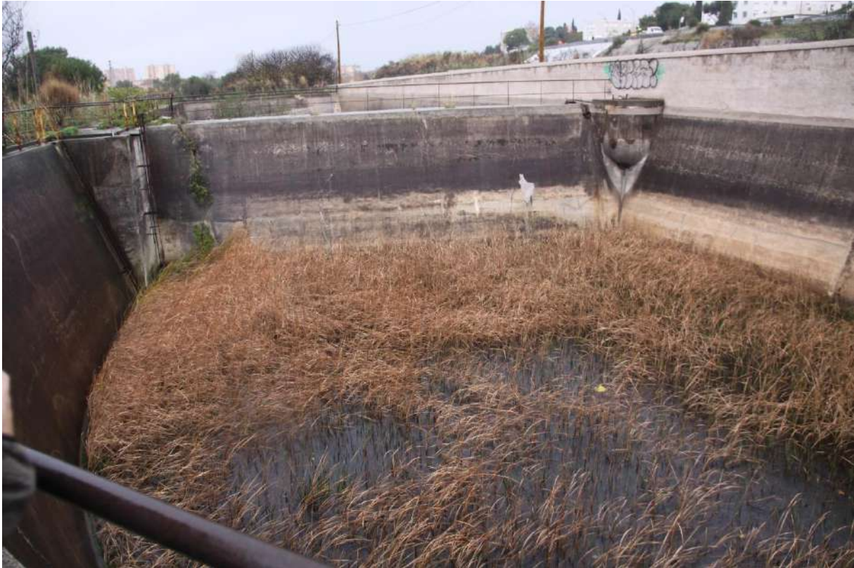
Figure 63 : Bassin de rétention présent sur le site d'étude
