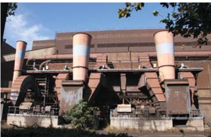
Dépoussiérage à l'entrée des matières aux hauts fourneaux de l'usine SOLLAC Méditerranée
