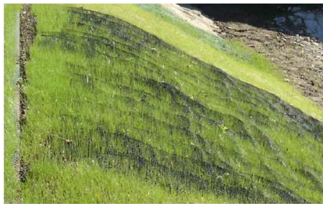
Exemple de stabilisation des pentes par la société Virens https://www.virens.fr/
