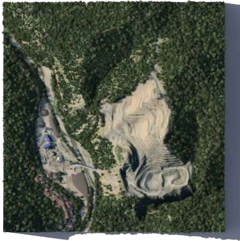
Phase 0 - Etat initial - vue aérienne
