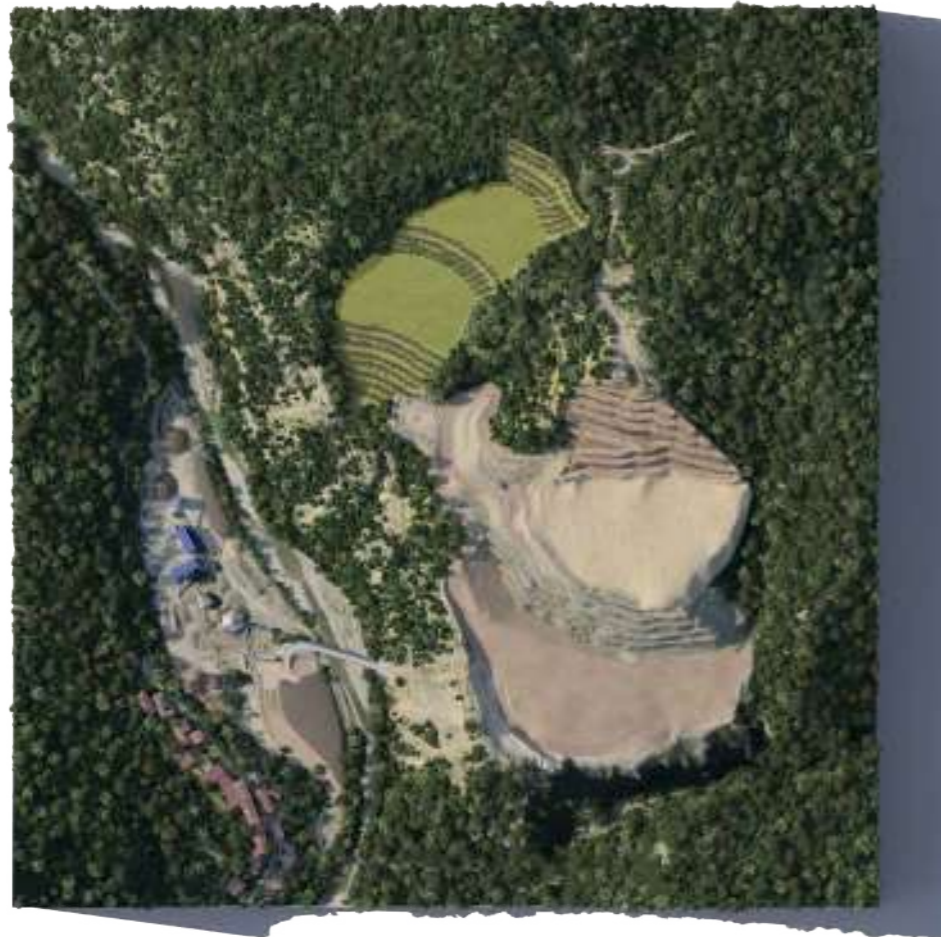
Phase 3 - vue aérienne
