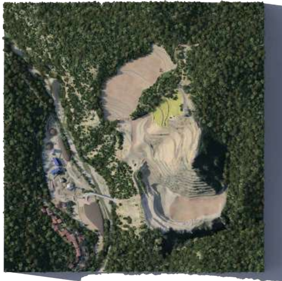
Phase 2- vue aérienne
