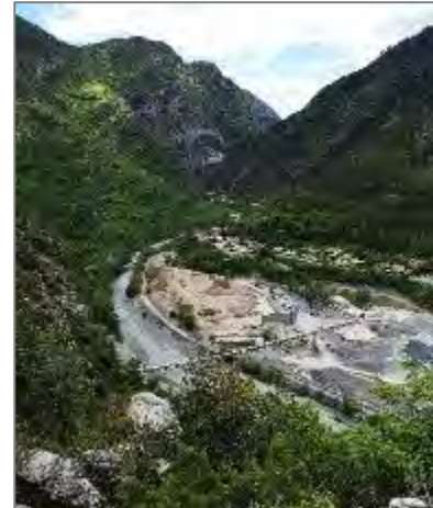
Figure 2-1 Carrière de la Courbaisse au sud
