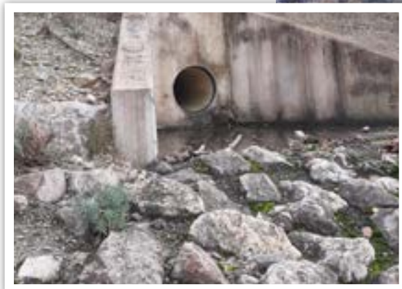
Ouvrage n°4, aval © LPO PACA
