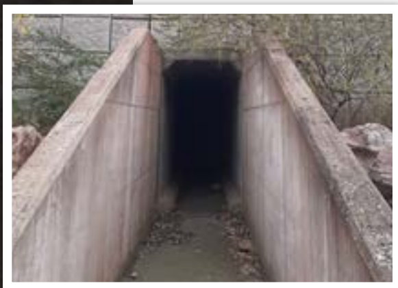
Ouvrage n°6, aval © LPO PACA
