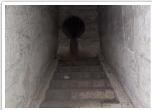
Ouvrage n°6, aval © LPO PACA
