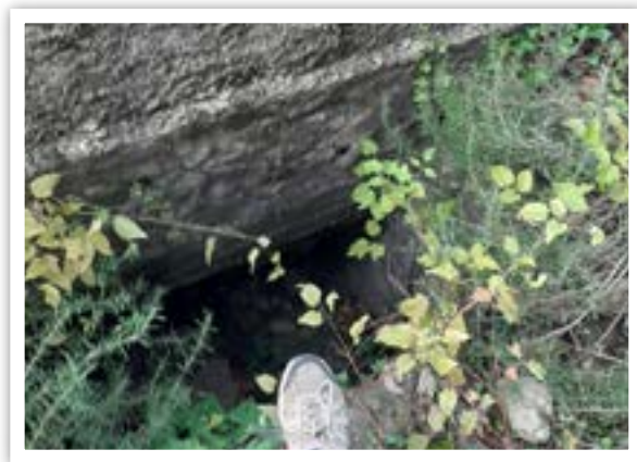
Ouvrage n°6, amont © LPO PACA
