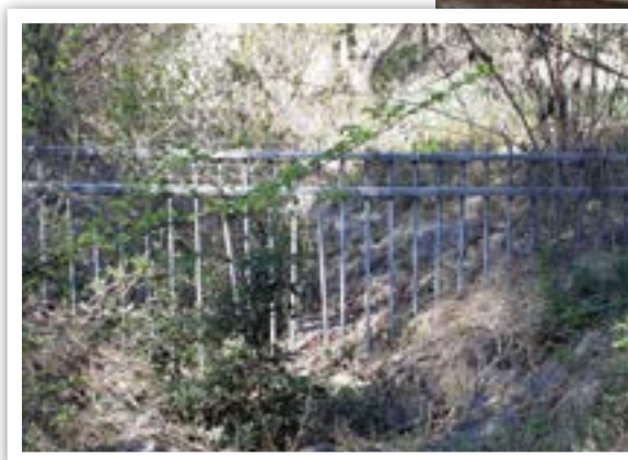
Ouvrage n°1, aval © LPO PACA
