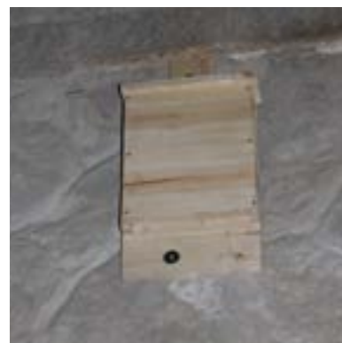
Gîte à chiroptères sous un pont © Camille PICARD
