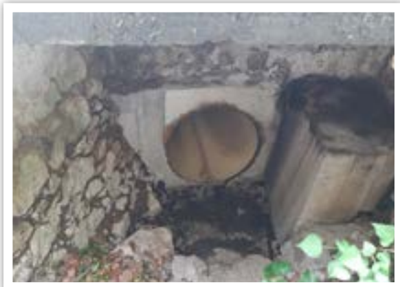
Ouvrage n°4, amont © LPO PACA
