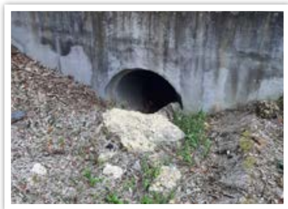
Ouvrage n°6, amont © LPO PACA
