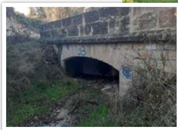
Ouvrage n°6, aval © LPO PACA
