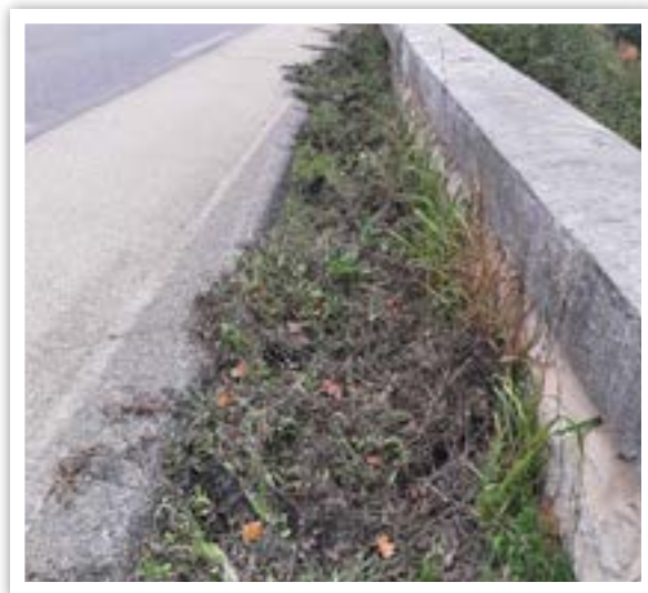
Ouvrage n°10, aval © LPO PACA
