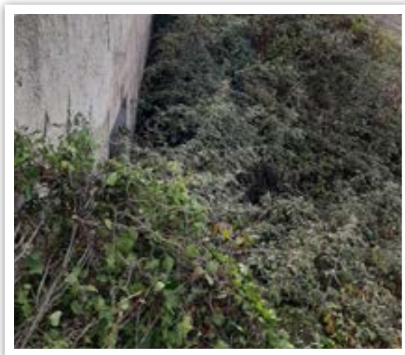
Ouvrage n°8, aval © LPO PACA
