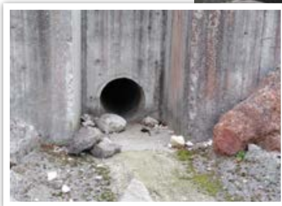
Ouvrage n°10, aval © LPO PACA
