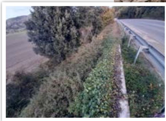
Ouvrage n°6, aval © LPO PACA
