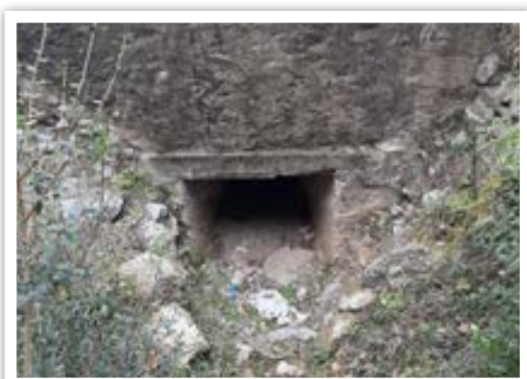
Ouvrage n°5, amont © LPO PACA
