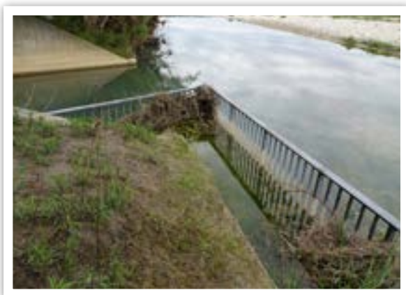
Ouvrage n°8, aval © LPO PACA
