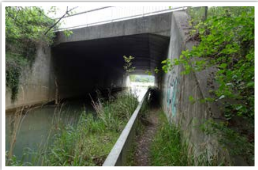
Ouvrage n°8, amont © LPO PACA
