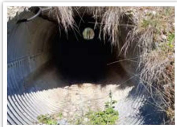
Ouvrage n°1, amont © LPO PACA
