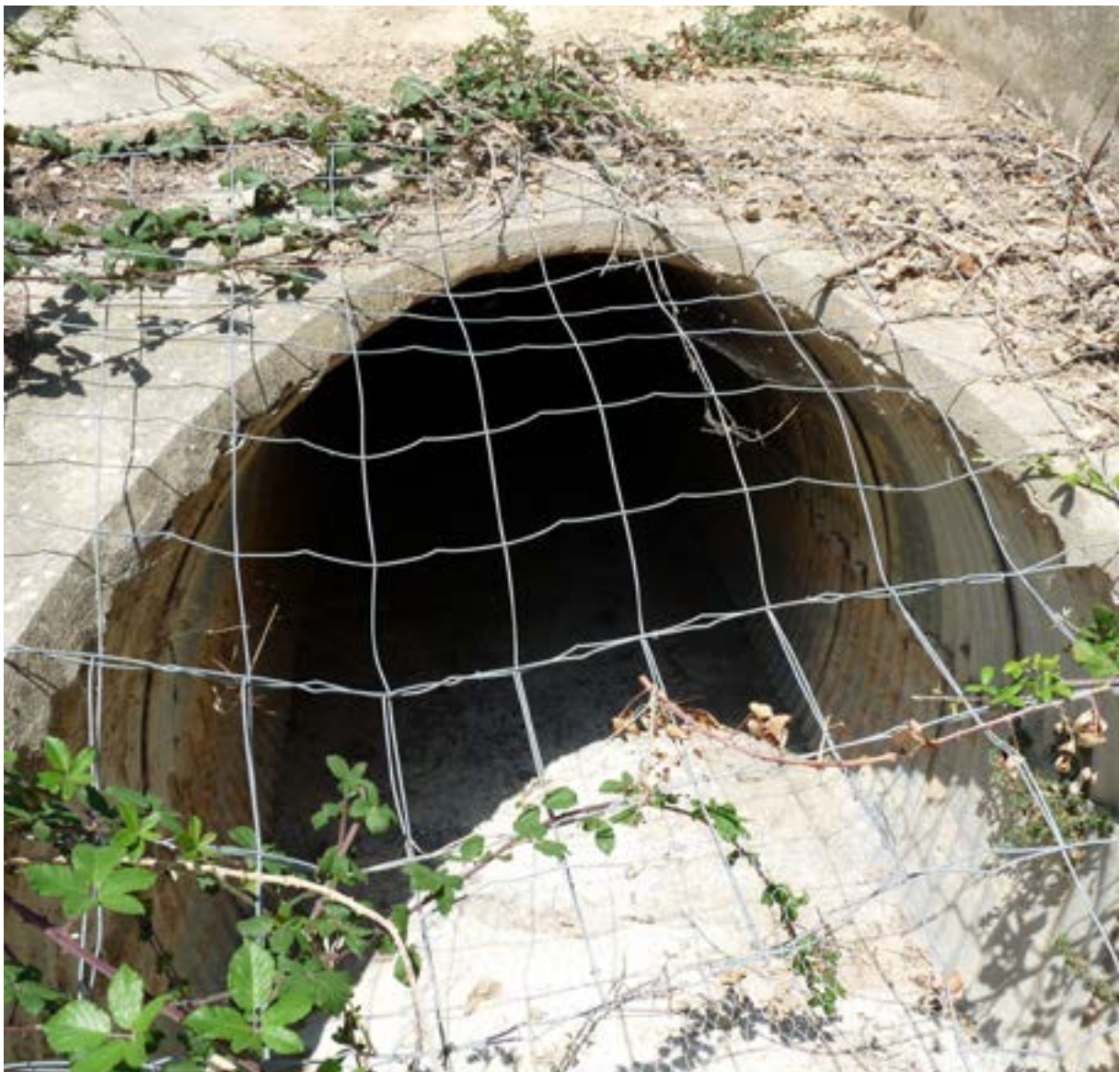
Buse parfaitement fonctionnelle pour la faune malheureusement condamnée par un grillage © Micaël GENDROT
