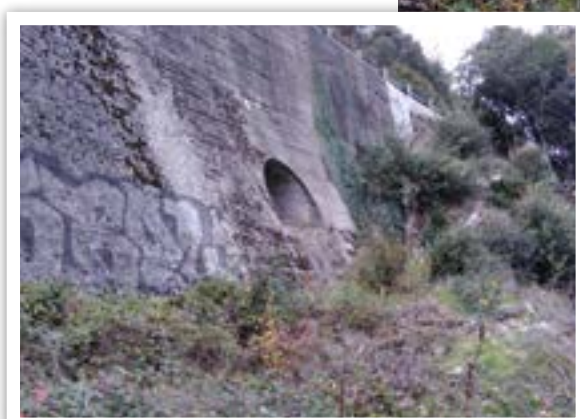
Ouvrage n°5, aval © LPO PACA
