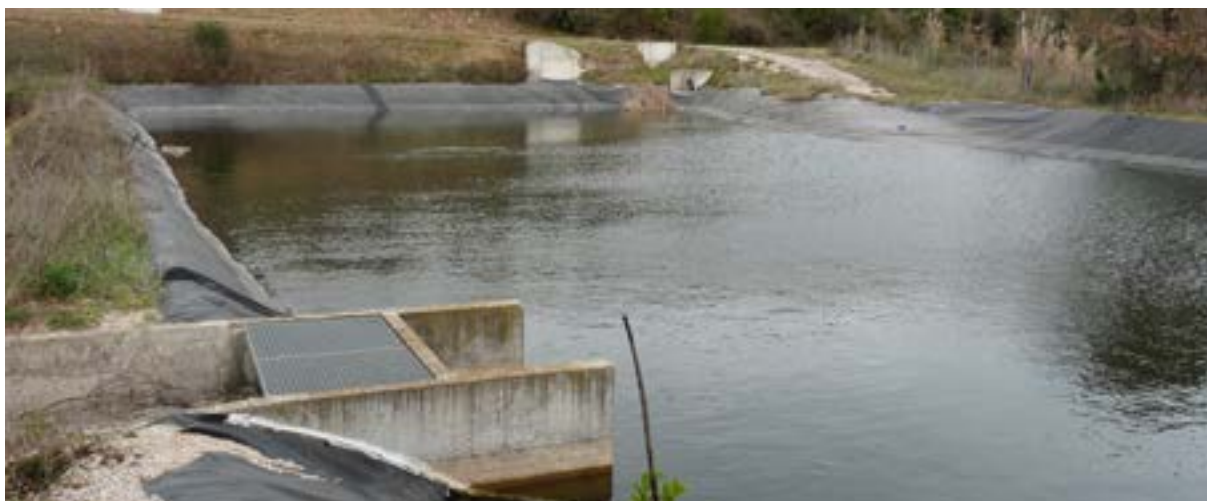
Bassin de rétention d'eau du réseau ESCOTA © Micaël GENDROT
