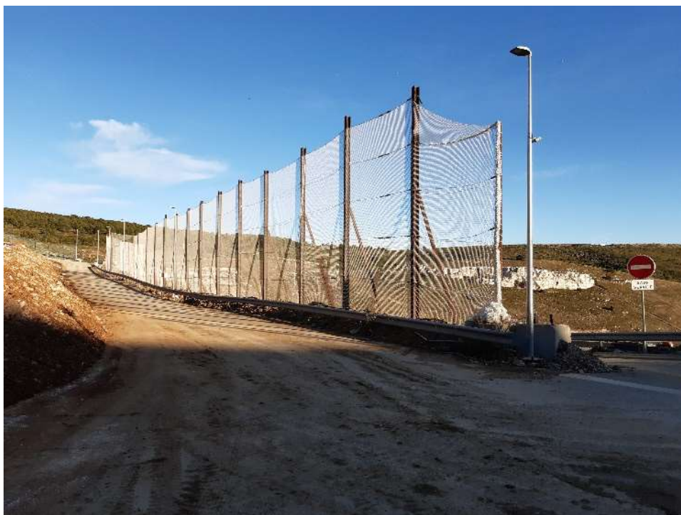
Ligne de filets sud remplacés à neuf fin 2020
