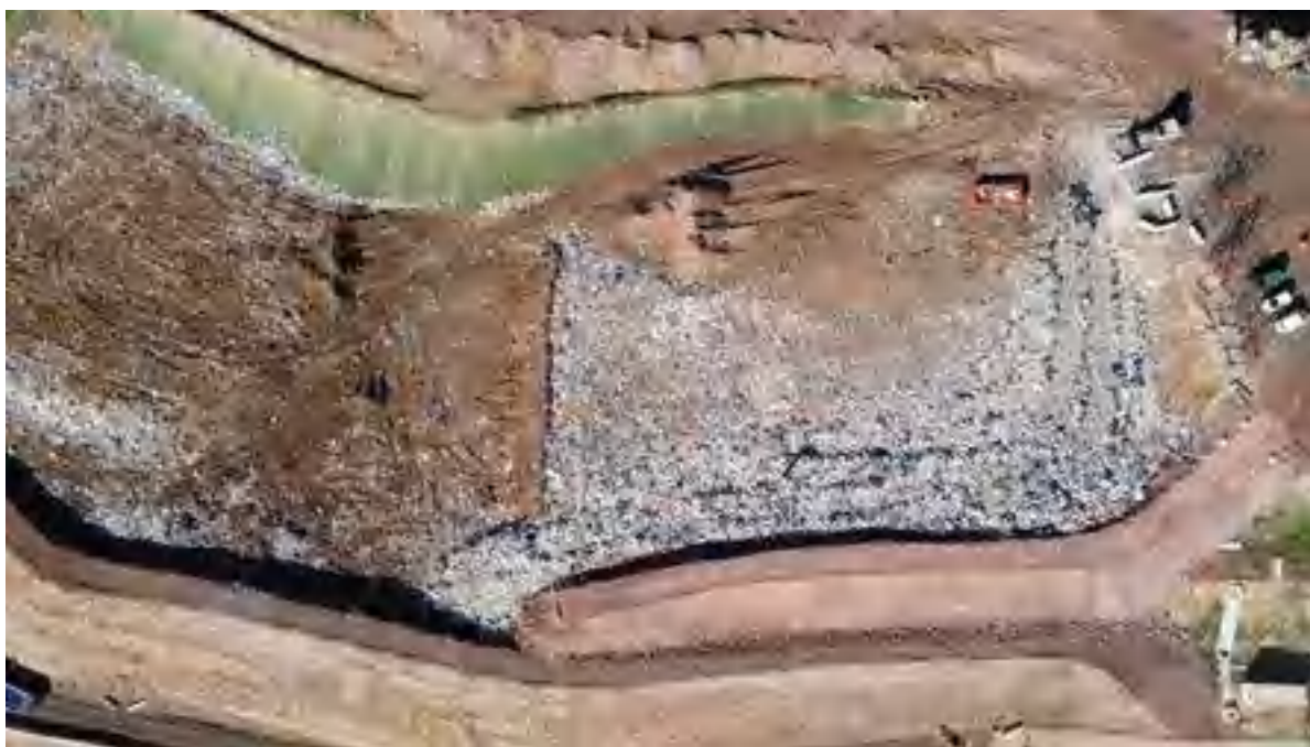
44. Confinement des déchets par des diguettes
