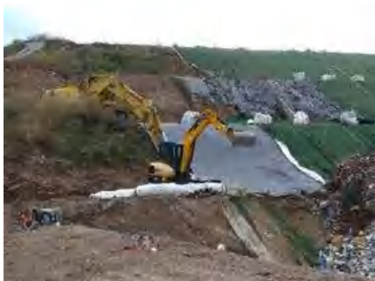
45. Incendie maîtrisé par les pompiers et travaux de reprise de la membrane
