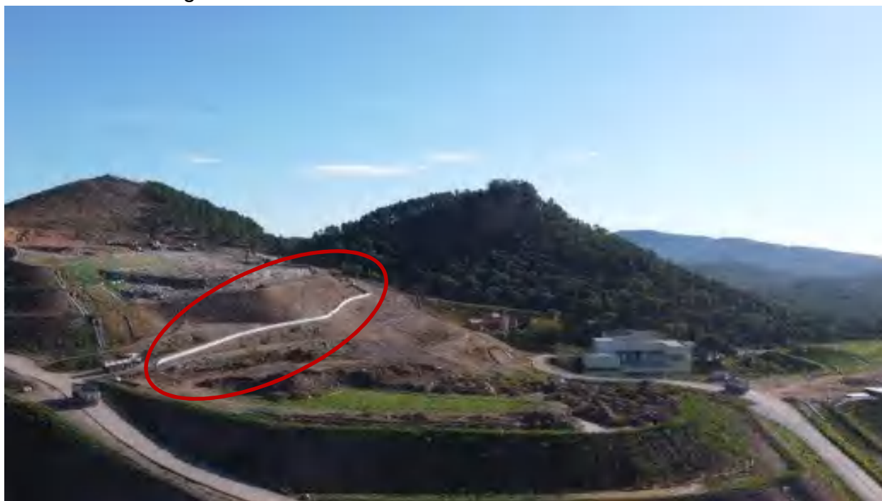
42. Piste Sud d'accès au nouveau quai de déchargement
