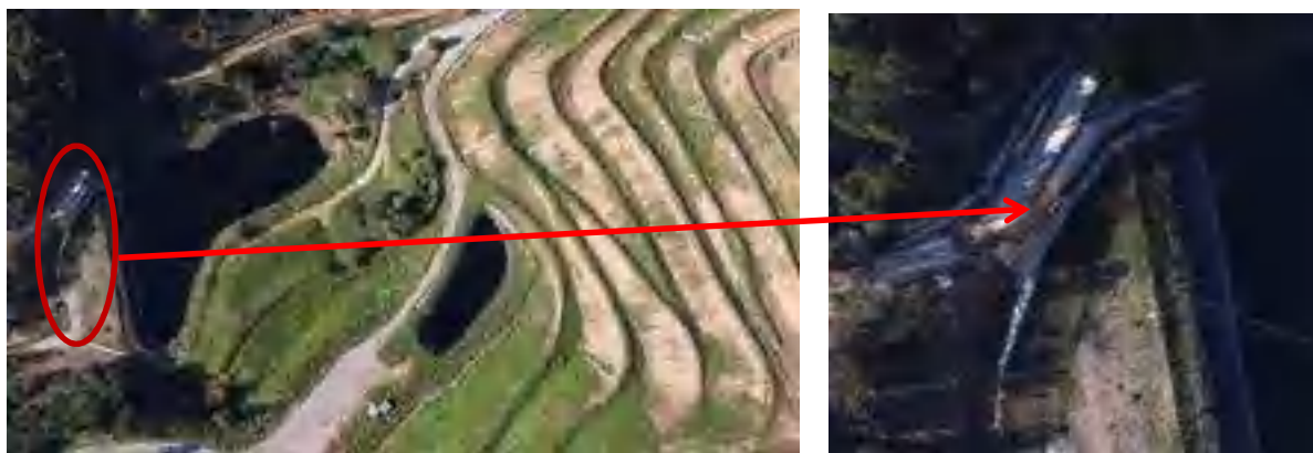
36. Travaux sur le pied et la rive droite de la digue de la lagune
