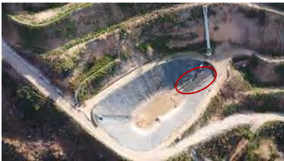
34. Retenue des Eaux Internes du site 3
