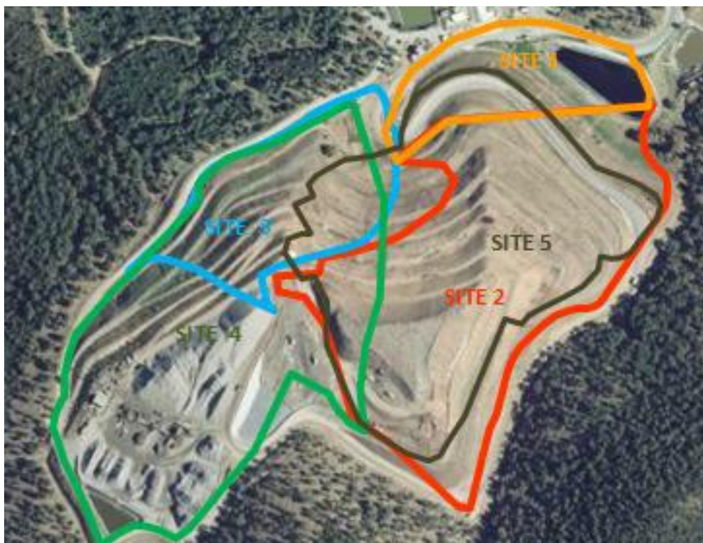
Figure 3 : Configuration actuelle du site et localisation des sites de stockage existants (Source AZUR VALORISATION)
