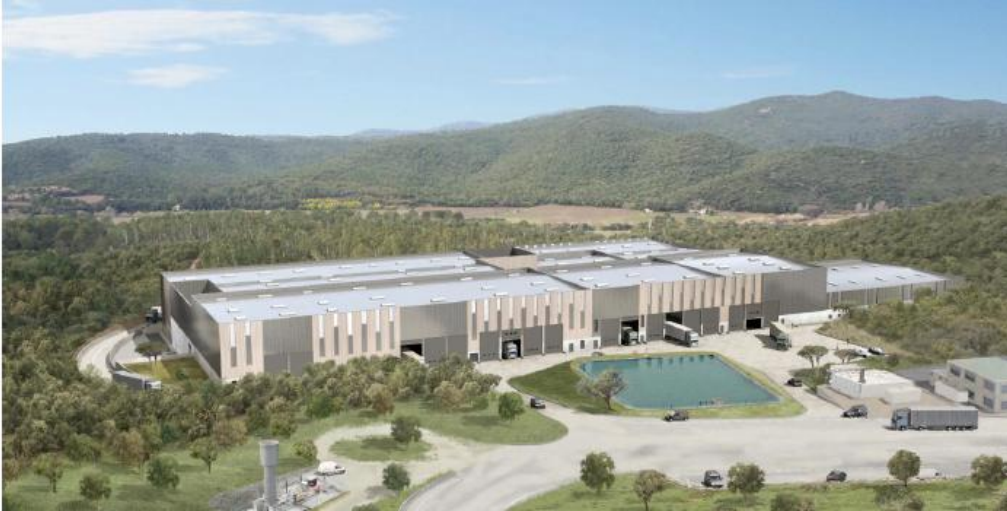
Insertion générale du bâtiment en fin de réalisation (phase 3) : vue vers le Nord (Source : AZUR VALORISATION)
