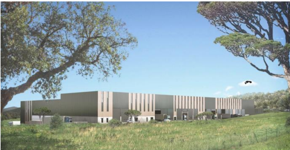
Insertion plus rapprochée du bâtiment (en fin de phase 3) : vue vers le Nord-Est (Source : AZUR VALORISATION)
