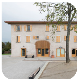
© V. Rigassi - Logements sociaux et commerces - Montseveroux (38)
