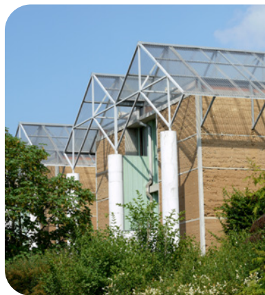
© CRAterre, T. Joffroy - Mur en terre
