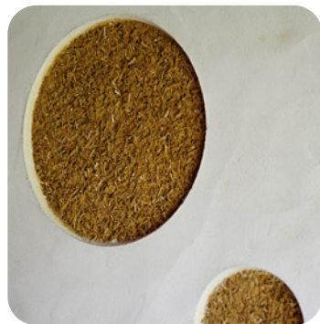
© Chanvriers en Circuits Courts - Enduit chanvre
