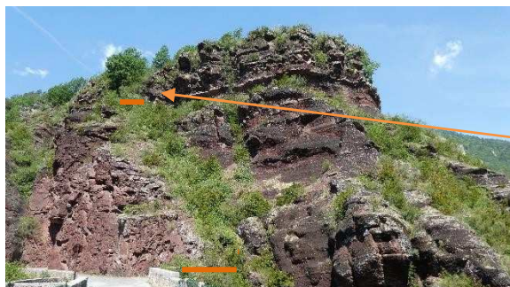
Zone prévue pour l'aménagement du chemin de descente au pont de la Mariée (Biotope & LPO PACA)
