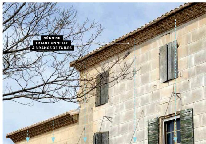
Figure 121 : Technique traditionnelle des génoises ou les débords de toitures en tuiles canals mettent à distance l'eau des façades
