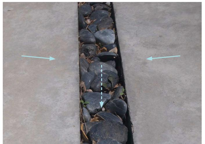
Figure 75 : Le fil d'eau traité en cailloux permet l'infiltration de l'eau, Sètes
