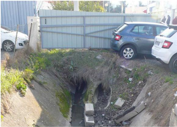
Figure 41 : Des canaux de gestion des eaux pluviales dégradés
