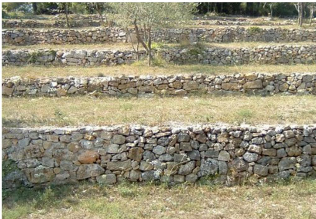
Figure 130 : Murs en pierres sèches appelés bancaous ou restanques
