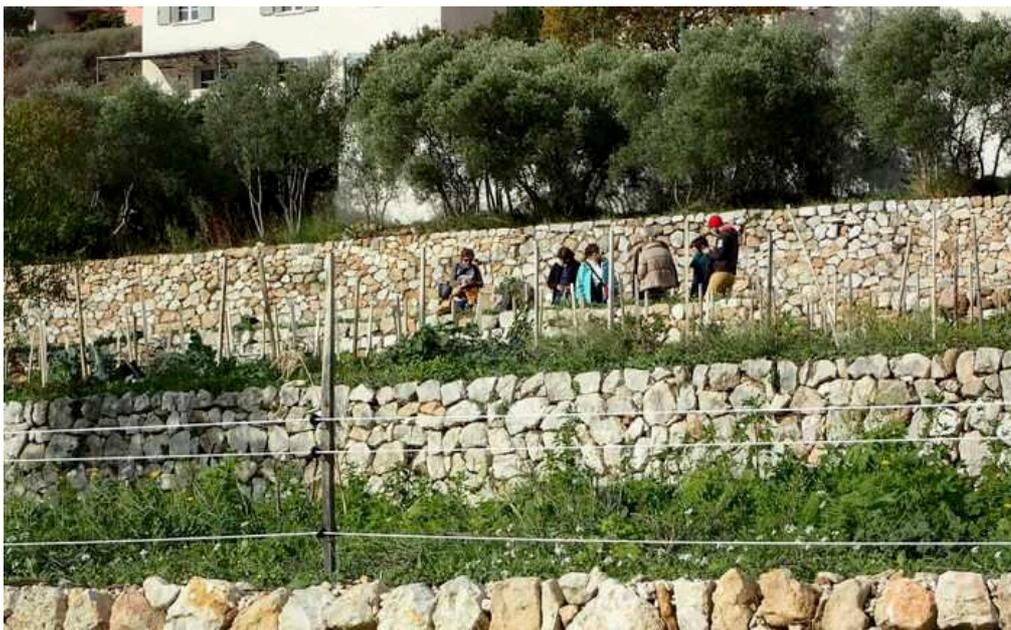
Figure 129 : Murs en pierres sèches appelés bancaous ou restanques
