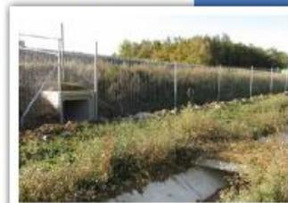
Passage inférieur parfaitement encadré par le grillage permettant de guider la faune vers les entrées
