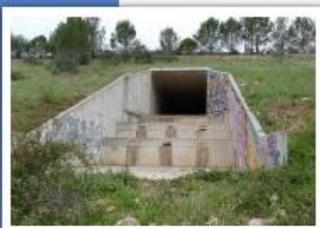
Triples seuils observés sur l'ouvrage n°②
