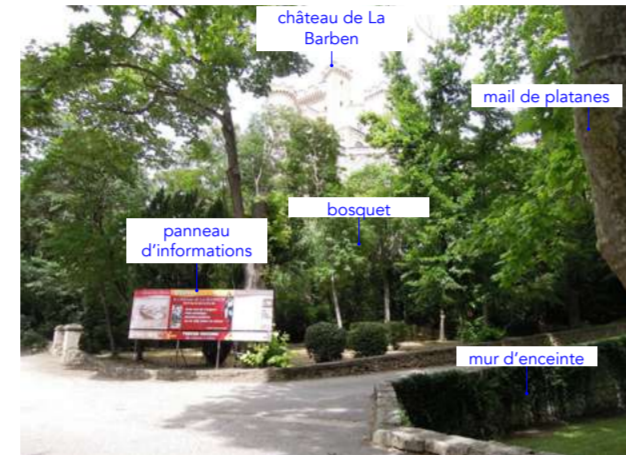
A. L'ENTRÉE PRINCIPALE DU CHÂTEAU
