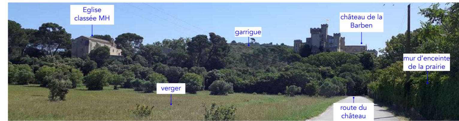
L'ÉGLISE SAINT SAUVEUR ET LE CHÂTEAU DEPUIS LA ROUTE DU CHÂTEAU
