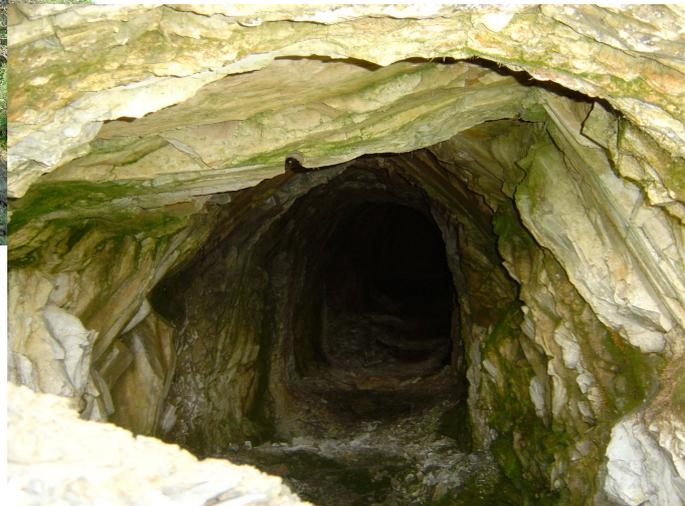
*Photographie 6 : Galerie pour schistes bitumineux dans une falaise en bord du Largue (INERIS, 2004)*
