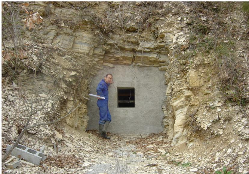
*Photographie 4 : Entrée d'une galerie pour schistes bitumineux dans le ravin du Bois d'Asson (INERIS, 2004)*
