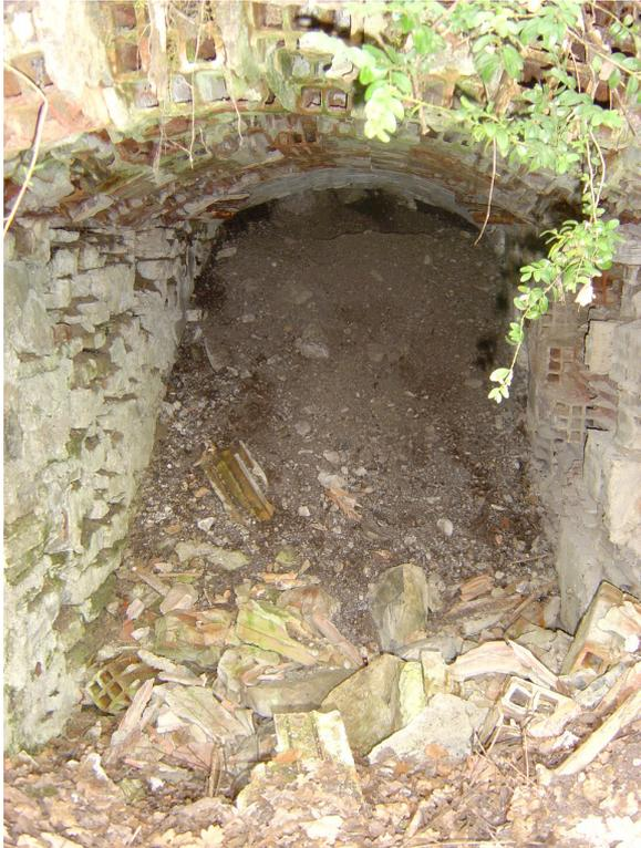
*Photographie 2: Entrée d'une galerie remblayée près du Puits du Collet Rouge (INERIS, 2004)*
