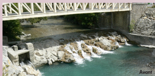
Ouvrage sur le Buech - Les Savoyons (Hautes-Alpes)
