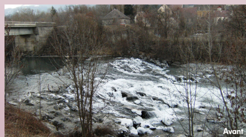
Ouvrage sur le Drac - Saint-Bonnet (Hautes-Alpes)
