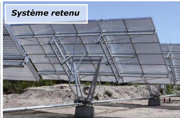
C'est le système CPV le plus léger en termes de dimension qui a été retenu (4,5 m). Avec des structures de dimensions plus acceptables il s'intégrera mieux dans l'environnement du site et nécessitera moins de travaux pour la mise en œuvre ainsi que la maintenance.
