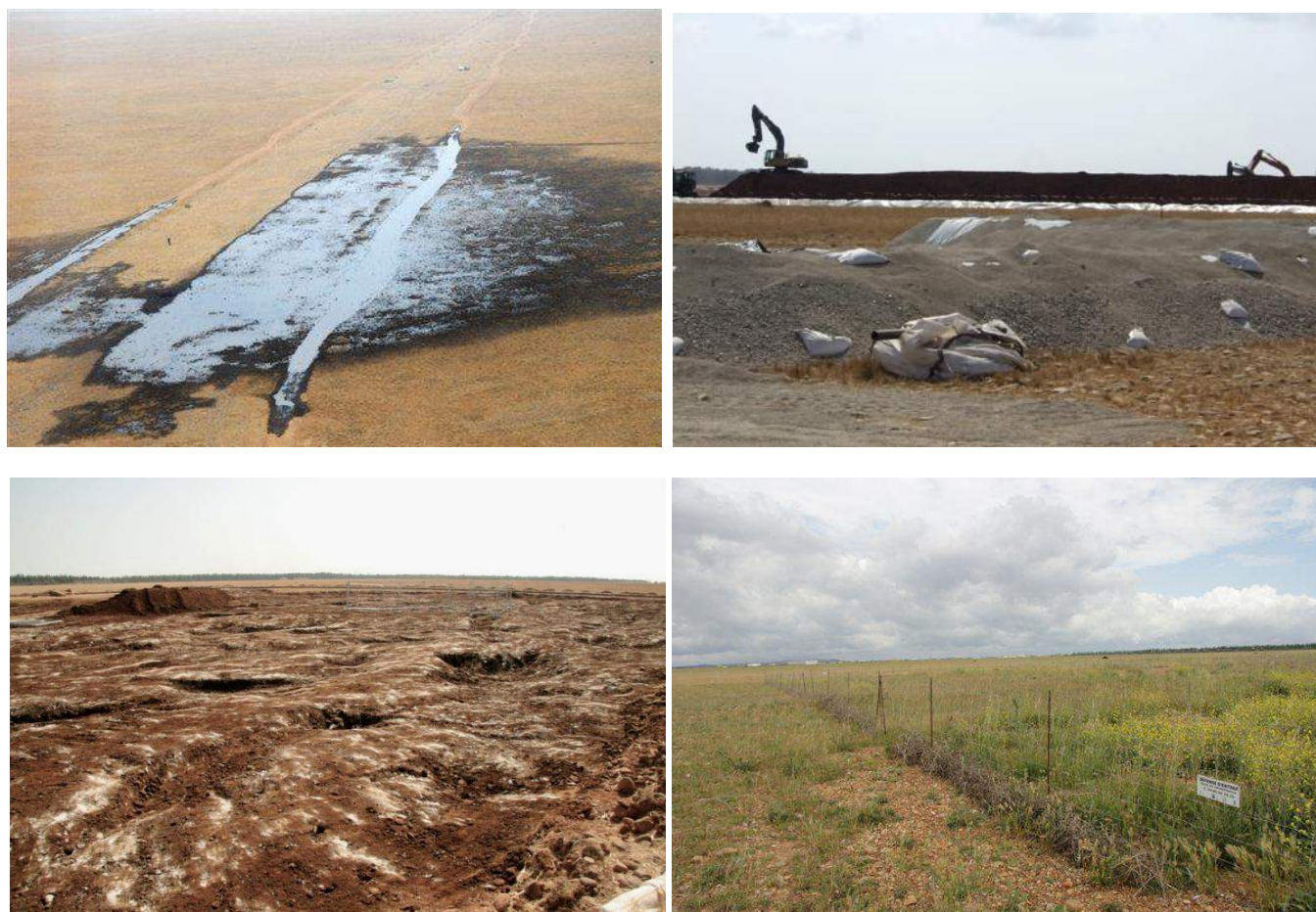
Figure 119. Illustrations de la fuite de pétrole brut le 7 août 2009. En haut : à g., la flaque de pétrole vue d'avion (photo SDIS 13) ; à d., illustration des dégâts supplémentaires causés par le chantier de dépollution avec le stockage de graviers sur le coussoul . En bas, à g., poudingue mis à nu après le décaissement des terres de surface imbibées de pétrole ; à d., état du site en 2014 après réhabilitation.
