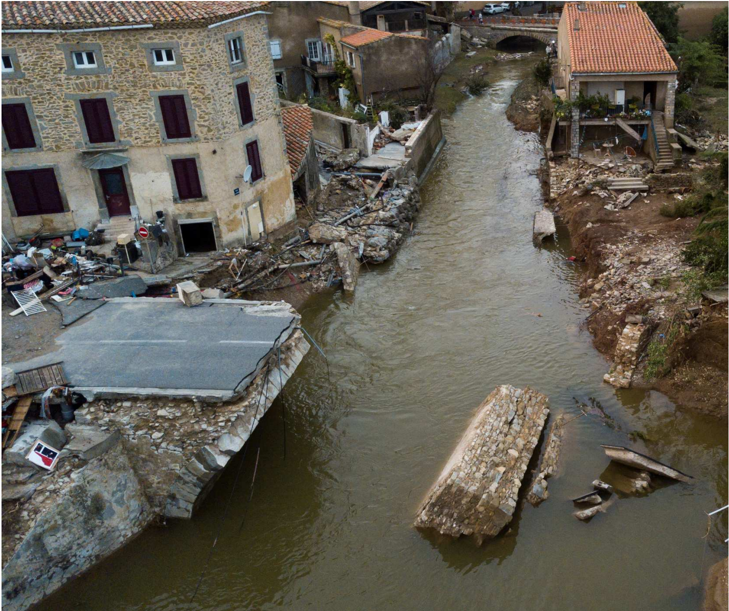
Photo : Sebastien Gominet/IRMA - Le pont de Villegailhenc (11) emporté par la crue du Trapel - 17/10/2008
